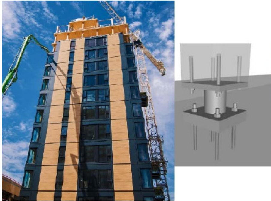
Figur 2.5: Till vänster Brock Commons i Vancouver under byggnadsskede och till höger anslutningsdetalj pelare-pelare. Bild: Structurlam (2016)
