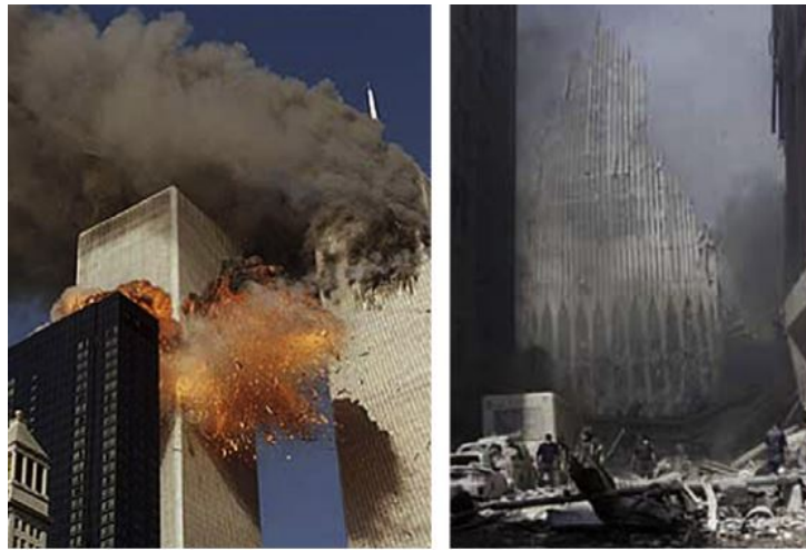
Figur 2.2: Till vänster WTC tornen efter flygplanskrasch. Till höger visas ena byggnaden efter fortskridande ras. Bild: Choi & Chang (2009)
