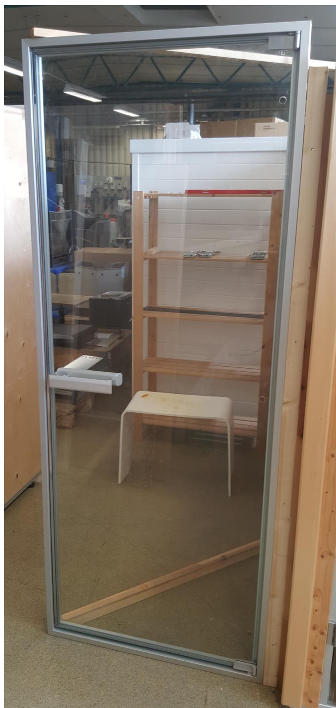
Figur 93: Hela dörren monterad i karmen
