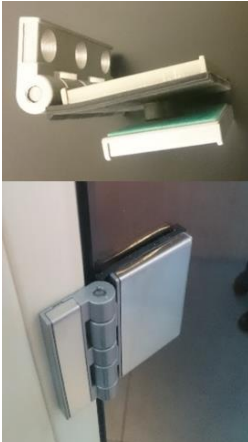
Figur 2: Tylös gångjärn som passar till dörr med tråkarm
