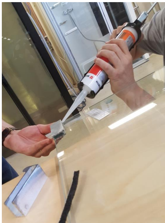
Figur 89: Hållaren limmas
