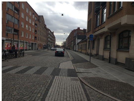
Figur 64. Nybyggda cykelfält och -banor längs med Stora Södergatan.
