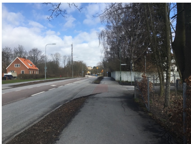
Figur 51. Tornavägen, sektion utan separering mellan gående och cyklister, med röd cykelöverfart vid korsningen med lokalgata.
