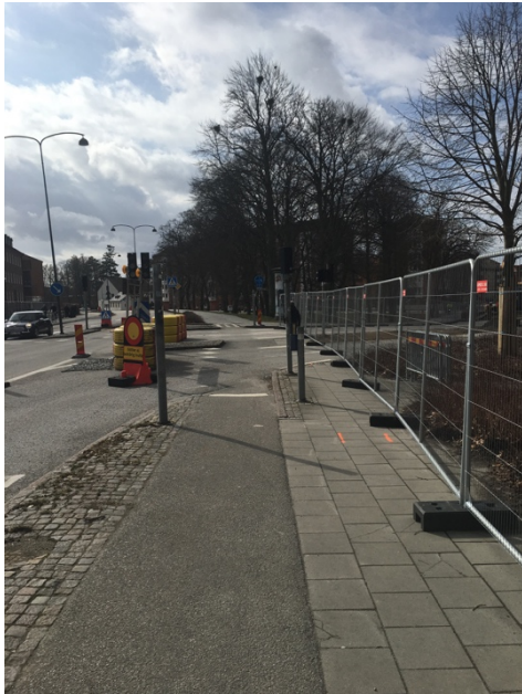
Figur 65. Vägarbete på Kung Oskars väg.
