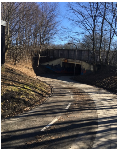
Figur 49. Skarp sväng norr om tunnel under Norra Ringen.
