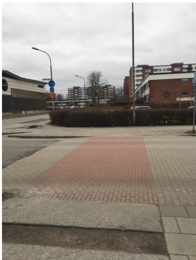
Figur 19. Gång- och cykelpassage med hål, nordlig riktning.
