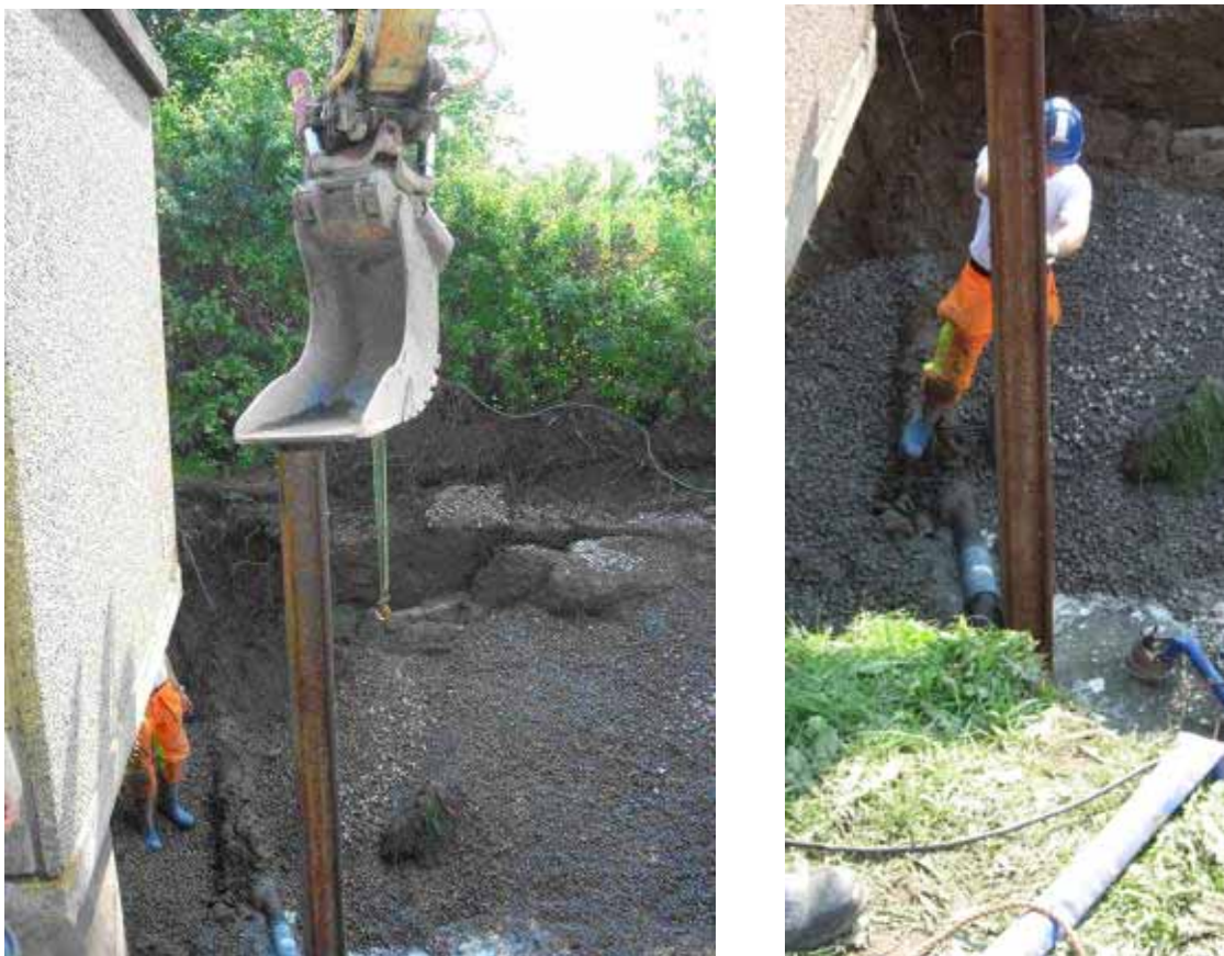
Figur 4.9 / 4.10 Västra Gryet – stabilisering
