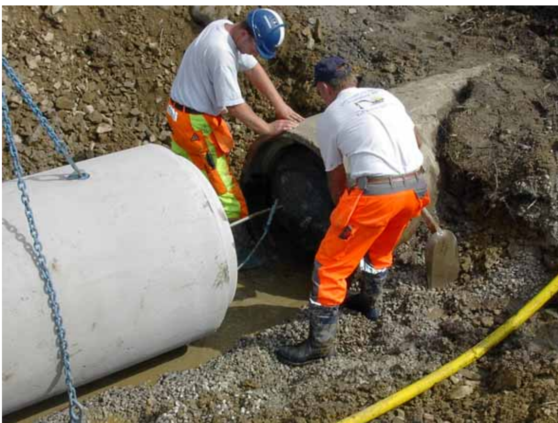
Figur 4.5 Västra Gryet – kulverten (koppling av rör)
