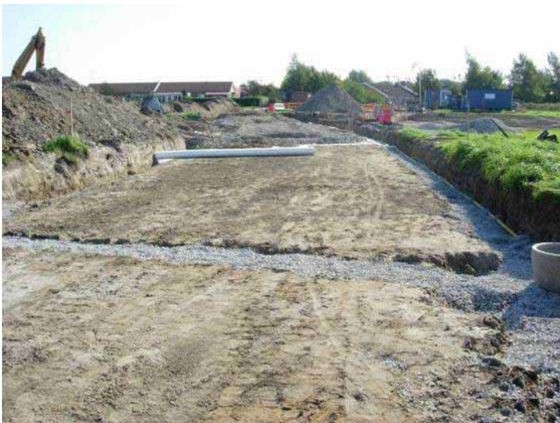
Figur 4.15 Västra Gryet – gatuarbete, fiberduk
