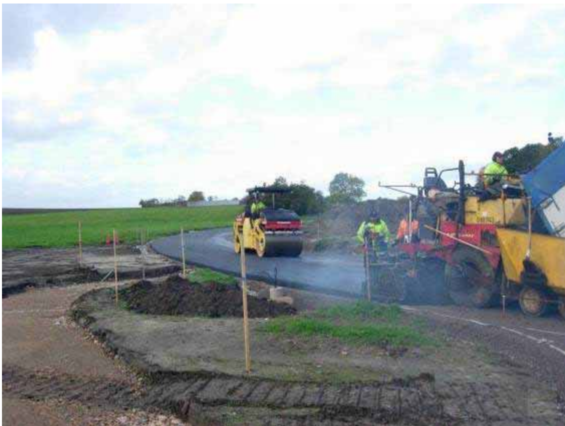
Figur 4.16 Västra Gryet – asfaltering
