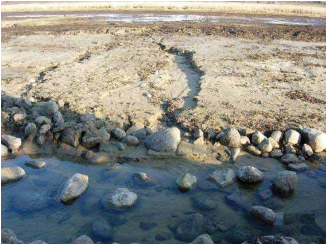
Figur 5.9 Västra Gryet – erosionskada
