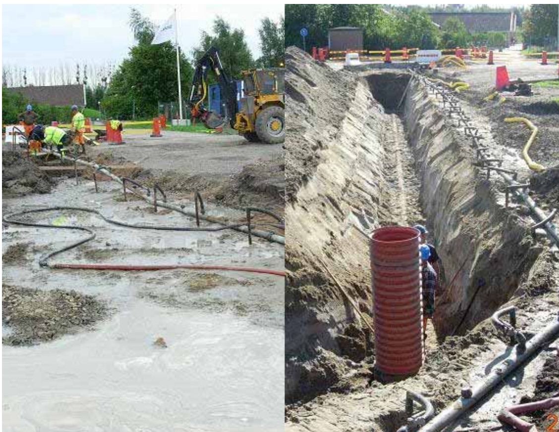
Figur 5.4 Västra Gryet – grundvattensänkning med wellpoint
