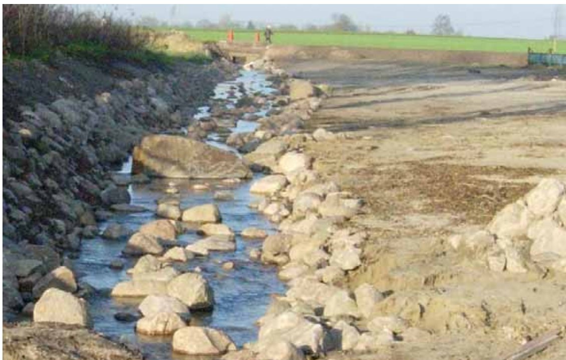
Figur 4.19 Västra Gryet – diket efter åtgärden
