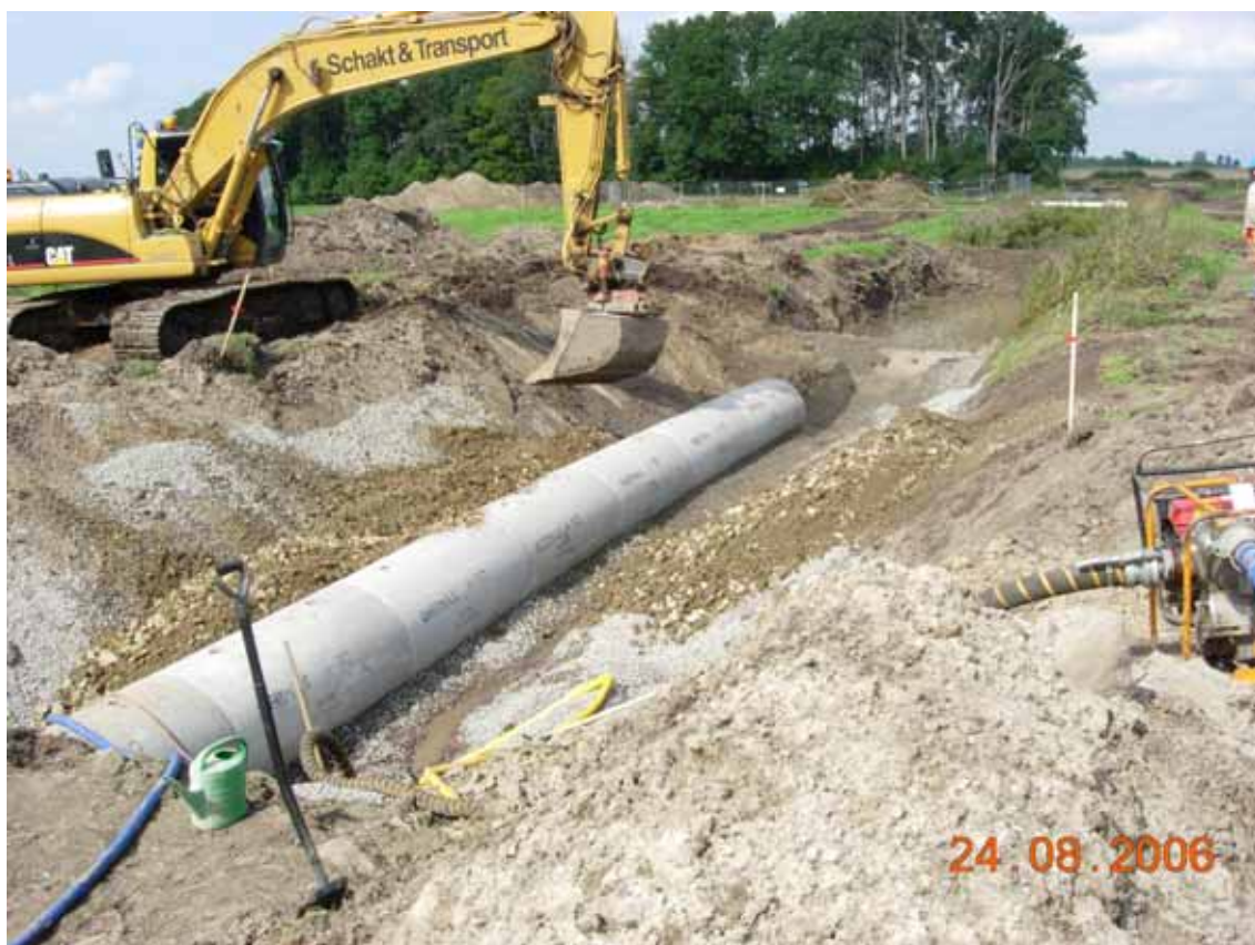
Figur 4.2 Västra Gryet – kulverten
