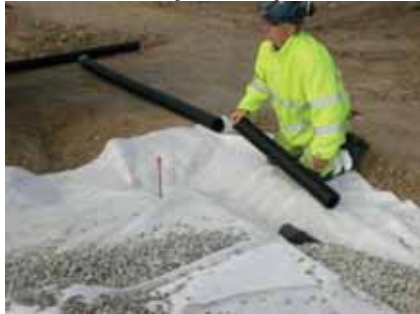
Figur 3.10 Materialavskiljande lager av geotextil.
