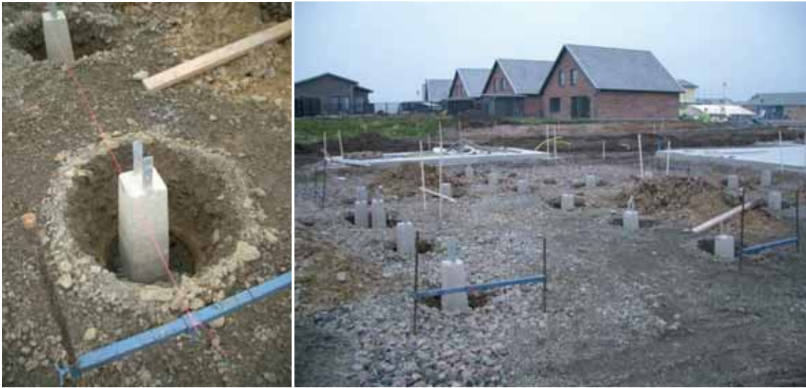
Figur 3.13 och 3.14 Plintsättning till carport
