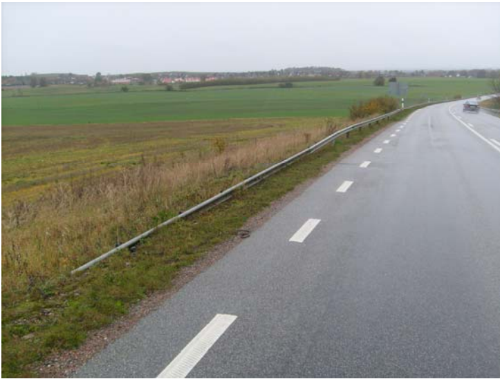
Figur 3.11 Navföljarförankring
