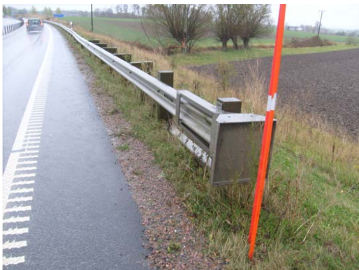
Figur 3.102 Energiupptagande vägräckesände
