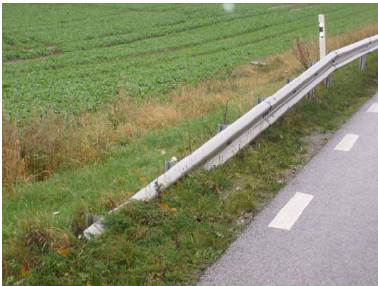
Figur 3.5 W-profilracket med kort neddoppad ände
