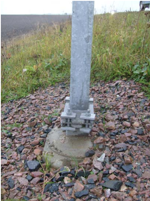
Figur 3.1 Stolpe med slipbase
