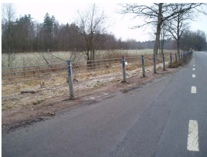
Figur 3.7 Stållineräcke
