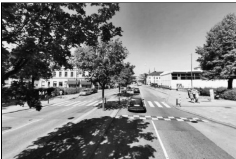
Figur 18. Upphöjd tillfart till övergångsställe som planas ut. Exempel från Amiralsgatan Malmö. Källa: Eniro.se, bearbetad av författaren
