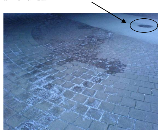
Rinnande vatten som frusit till is p g a olämplig placering av brunn.
