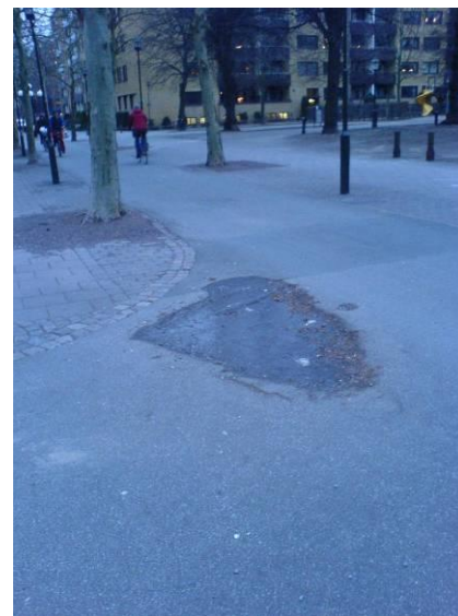
Isyta på cykelväg till följd av bristfällig avvattning
