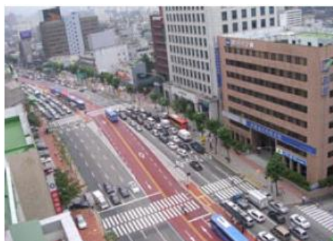
Figur 12 - BRT-system med färgad asfalt (ITDP, 2007)
