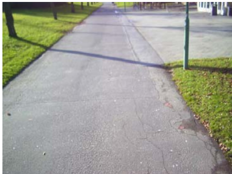
Sektion: 7850: Rambölls beräkningsmodell klassificerar sektionen med en dålig komfort till följd av den krackelerade och ojämna beläggningen.
