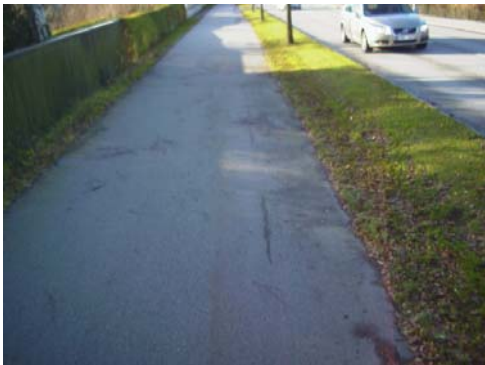
Sektion 5910: Ojämnheter i kanten av cykelvägen härleds vara orsaken till att VTI har klassificerat vägens komfort i denna sektion som mindre bra.
