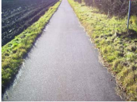
Figur 7.3 Sektion 79 - Ramböll har klassificerat denna sektion som komfortmässig dålig vilket kan kopplas till de sättningsrelaterade ojämnheter som kan urskiljas på bilden.
