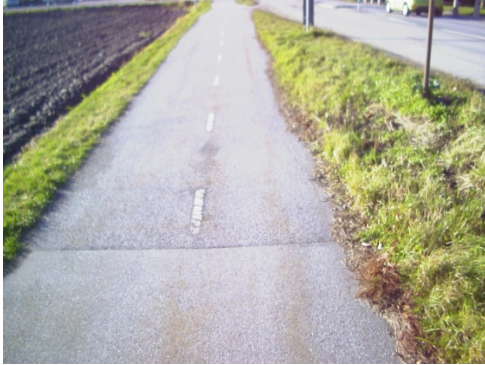
Sektion 4810: En mindre skarv vid beläggningsskiftet påvisar en dålig komfort enligt VTI.
