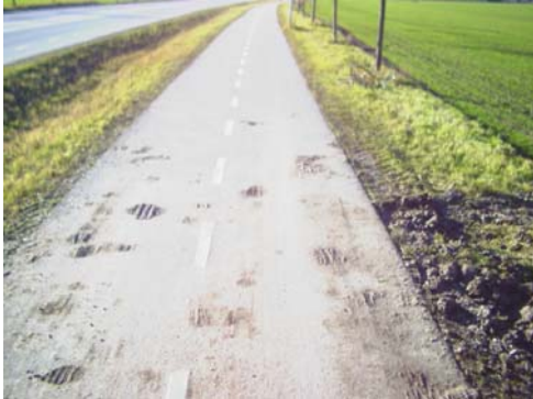
Sektion 1620: Resultatet från sektion 1550 till 2090 kan inte anses helt tillförlitligt på grund av de lerkockor efter jordbruksfordon som syns i bilden.
