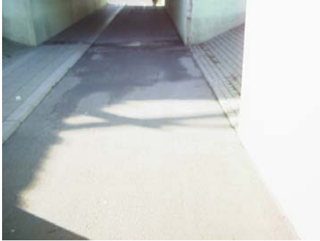
Sektion 7500: Gallerbrunnar i cykeltunneln härleds vara anledningen till den av modellerna påvisade dåliga komforten i sektionen
