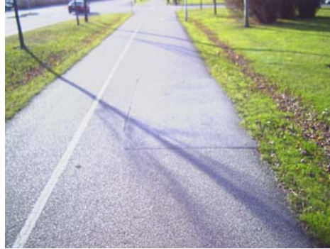
Sektion 9900: I sektionen ovan syns en för delsträckan signifikativ lappning som föranleder en dålig komfortklassificering av VTI:s beräkningsmodell.
