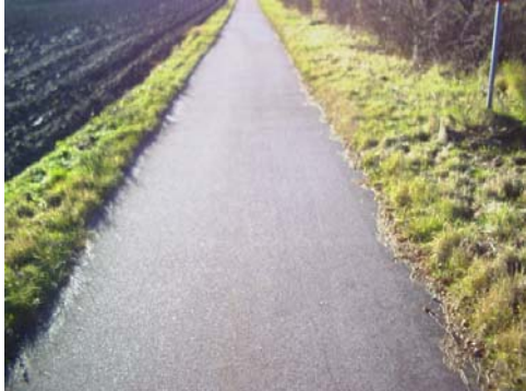
Sektion 790: Rambölls låga komfortvärde över denna sektion av mätsträckan kopplas till de utbredda sättningsrelaterade ojämnheter som vagt kan urskiljas på bilden.
