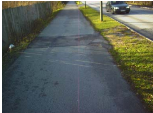
Sektion 5830: I delsträcka E återfinns ett antal mindre bra skarvar vid lappningar vilka härleds vara orsaken till att båda modellerna ofta i enighet med varandra påvisat en dålig komfort i dessa sektioner.
