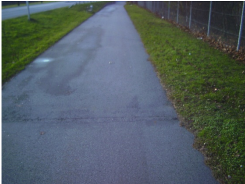
Sektion 7140: Skarv vid byte av beläggning vilket kan kopplas till den medelbra komfort som beräknats av VTI:s beräkningsmodell.
