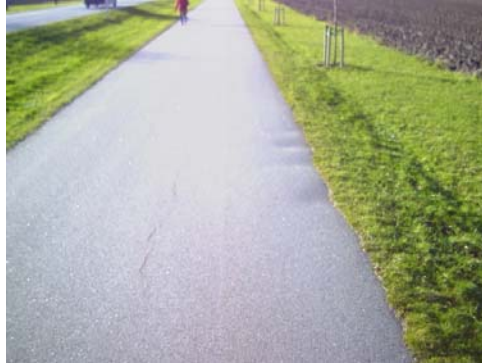
Sektion 6930: Vid sektionerna 6930,6940, 7040 samt 7060 återfinns kantsättningar likt de på bilden, dessa härleds vara orsaken till att VTI:s klassificerat sektionerna som dåliga.
