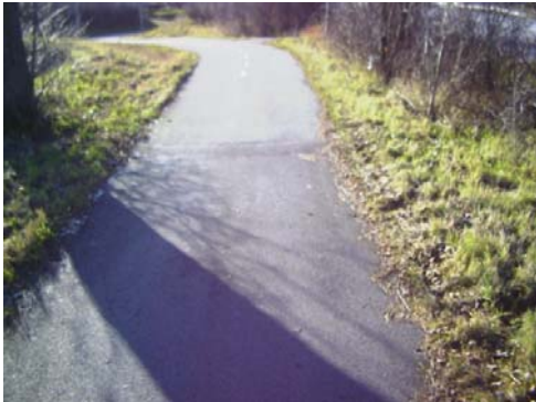
Sektion 1330: Ojämnheten som står att finna vid skiftet av beläggningstyp har enligt VTI:s beräkningsmodell medfört en dålig komfort.
