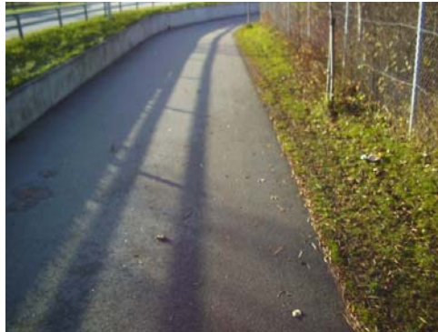
Sektion 7240: De små kvistar och löv som återfinns på vägbanan härleds vara anledningen till att båda beräkningsmodellerna klassificerat sektionen som dålig.
