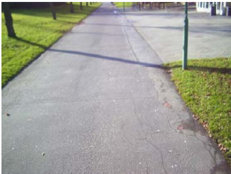
Figur 7.8 Sektion som enligt Rambölls beräkningsmodell klassificeras som komfortmässigt dålig till följd av den krackelerade och något ojämna beläggningen.
