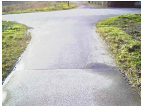
Sektion 250: I sektion 250 återfinns ett antal mindre kantigheter i belägningen vilka har erhållit ett större utslag i VTI:s komfortvärde.
