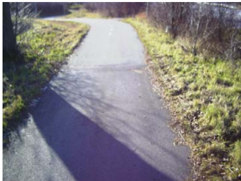
Figur 7.5 Sektion 1330 - Ojämnheten som står att finna vid bytet av beläggning har enligt VTI:s beräkningsmodell medfört en för sektionen dålig komfort.
