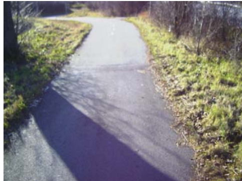
Figur 7.11 Sektion från som enligt VTI:s beräkningsmodell har påvisat dålig komfort på grund av kanten vid beläggingsbytet.
