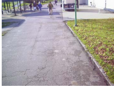
Sektion 7760: En krackelerad och något ojämn beläggning härleds ligga till grund för att Rambölls komfortvärde påvisat en dålig komfort.
