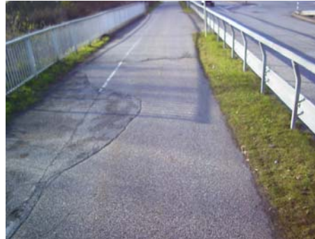
Sektion 10310: Ojämnheter som kan kopplas till en lappning och beläggningsbyte. Sträckans komfort har enligt VTI:s beräkningsmodell klassificerats som medelbra och enligt Rambölls beräkningsmodell som dålig.
