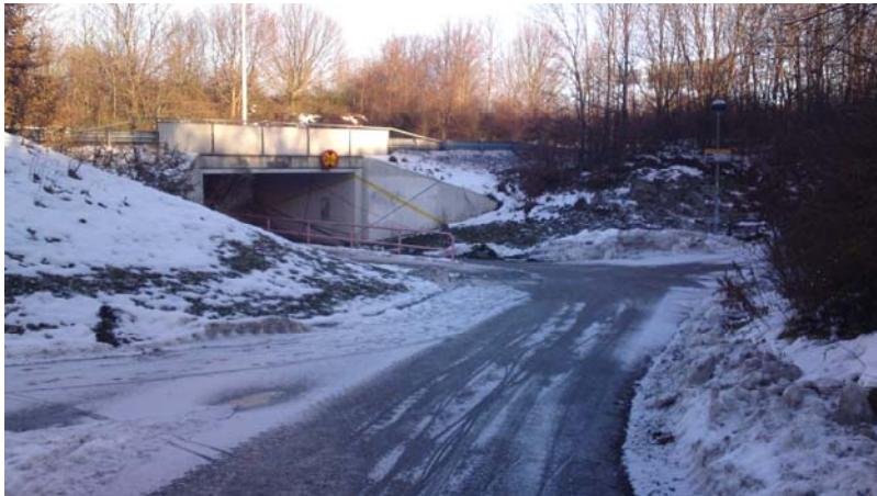
Figur 38 Gång- och cykeltunnel under Norra Ringen.
