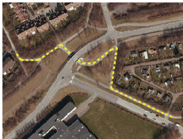
Figur 57 Gula huvudcykelstråkets korsning med Nöbbelövsvägen efter ombyggnad.
