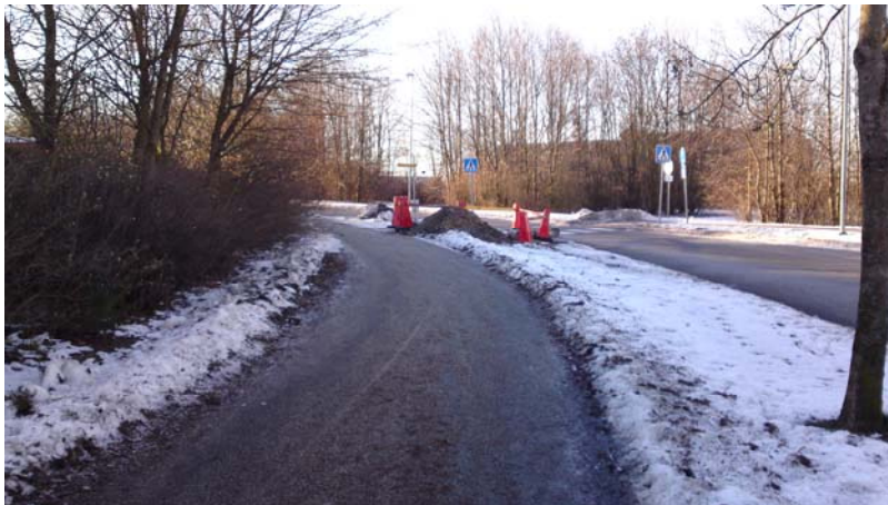
Figur 47 Nordvästra hörnet på Rudeboksvägen i sydvästlig riktning.
