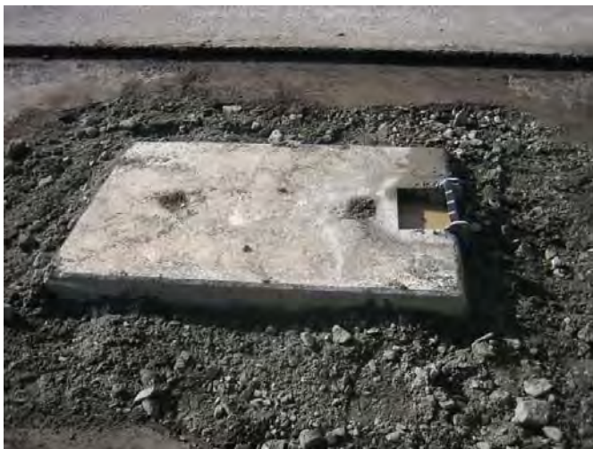
Figur 3.11. Prefabricerat betongfundament på E6, Trelleborg. ©Författarna
