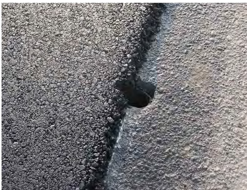
Figur 4.3. Stolphål på E6 Trelleborg ©Författarna
