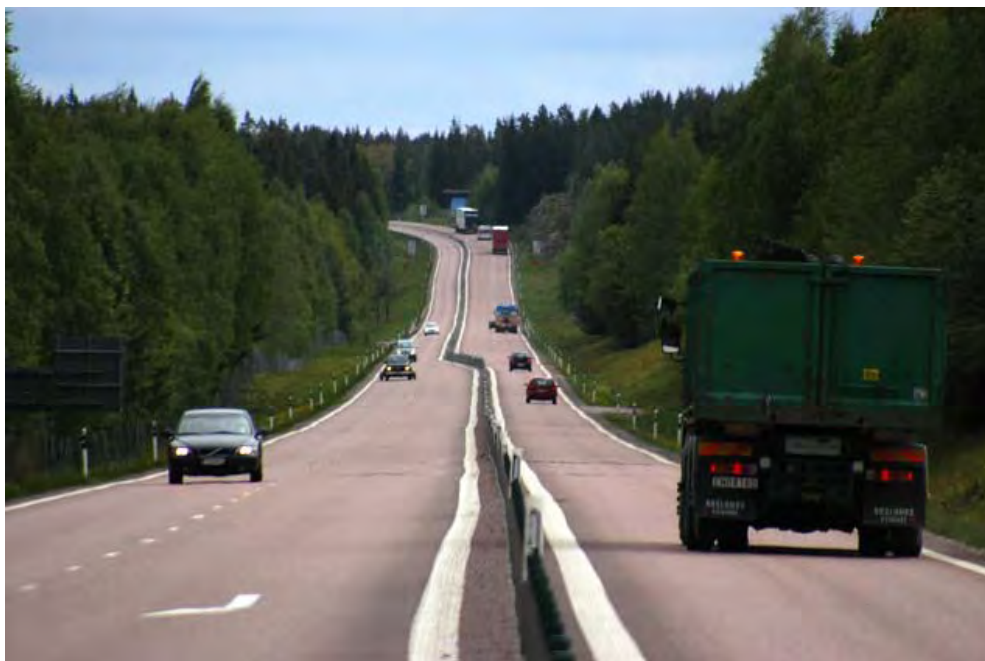
Figur 3.2. Sammanvävningsfält på en 2+1-väg. Fotograf Thorsten Alm (Trafikverket, 2010e)
