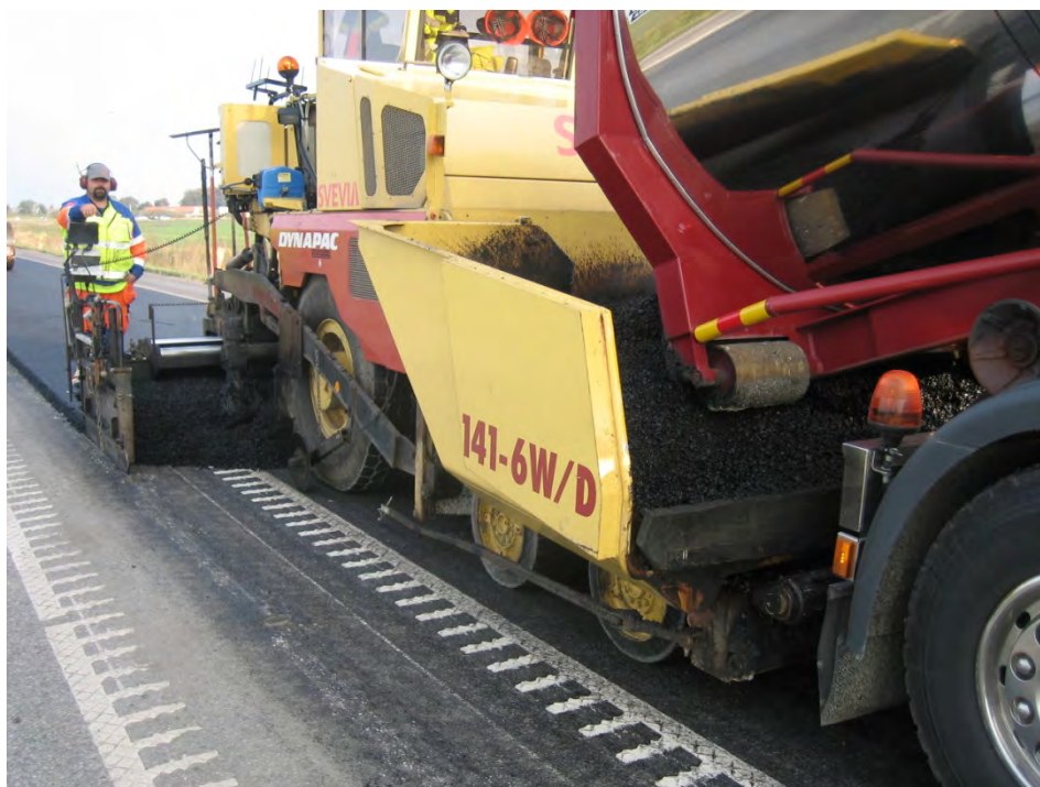
Figur 3.7 Utläggning av bindlager på E6 i Trelleborg. ©Författarna
