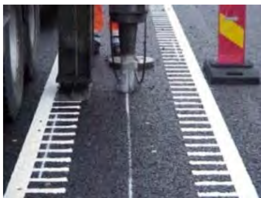
Figur 3.14. Hålslagning för mitträckets stolpar. (Blue Systems, 2010)
