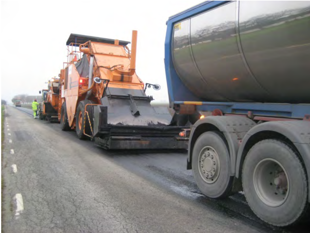
Figur 4.7. Shuttle-buggy tar emot asfaltmassa och fyller asfaltsläggaren. ©Författarna
