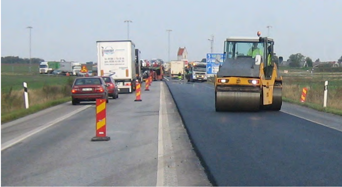
Figur 4.4. Enkelriktad trafik vid beläggningsarbetet på E6 Trelleborg-Maglarp ©Författarna
