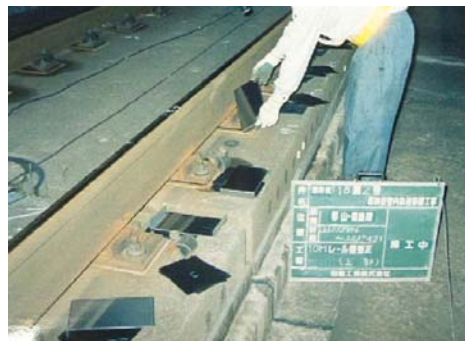
Figur 17, vertikal justering utförs förhand, (Yokoyama, 2007)
