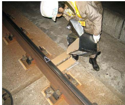
Figur 19, en arbetare som håller i det speciella harts materialet med glasfiber (Yokoyama, 2007)
