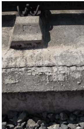
Figur 25, sprickor mellan betongtråget och platsgjutna betongen i Rheda Classic (Stolz, 2010)
