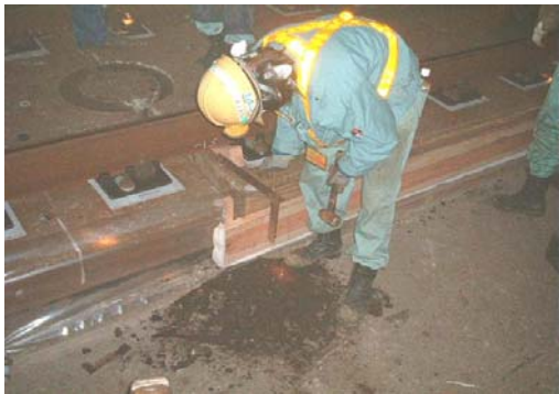
Figur 20, montering av träramen innan gjutning av hartsprodukten (Yokoyama, 2007)
