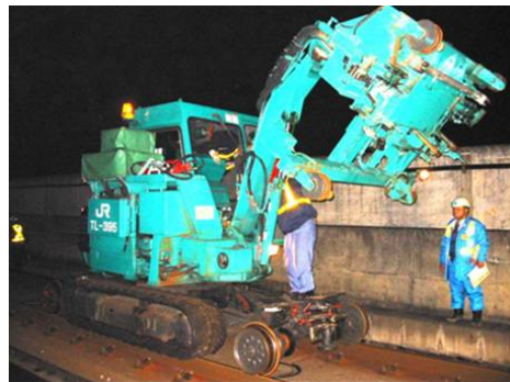
Figur 16, det Japanska spårjusteringsfordonet Track Liner (Yokoyama, 2007)
