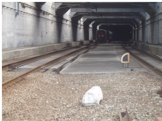
Figur 29, är taget innan det att övergångszonen byggdes om i Öresundsförbindelsens tunnel (Lundgren, 2010)
