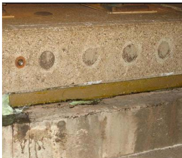
Figur 22, färdigt resultat efter reparation av bruket med den speciella hartsblandningen (Yokoyama, 2007)
