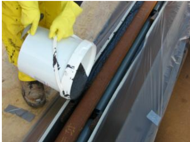
Figur 27, Corkelast hälls ner i rännan och omsluter rälen (EdilonSedra, 2010)
