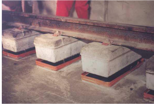
Figur 28, visar när blocken i LVT systemet lyfts upp (Sonneville, 2009b)
