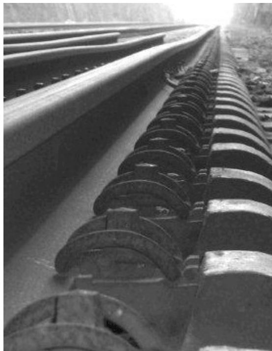
Figur 30 visar ett längsgående höjdfel i en övergångszon mellan ett fixerat och ett ballastspår, källa Stolz (2010)
