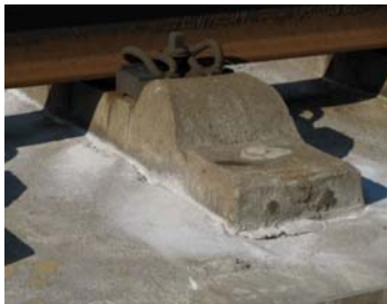
Figur 24, en monoslipper som är ofixerad mot betongen i Rheda Classic (Stolz, 2010)
