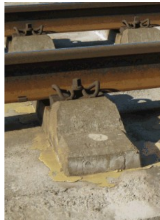
Figur 26, hur en lagning av en ofixerad slipper med hjälp av epoxiharts (Stolz, 2010)
