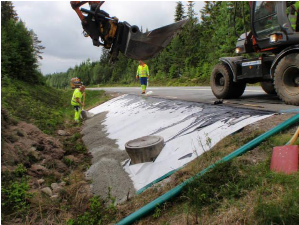
Figur 36 - Tätning av innerslät med duk (Hansson et al., 2012)
