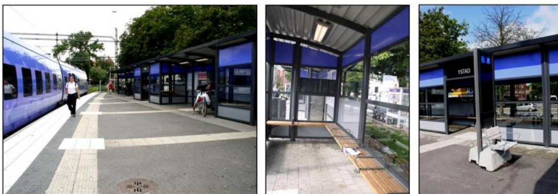
Figur 27. Bilderna är tagna från plattform 1 och visar utformningen av plattformen samt väderskydden.
