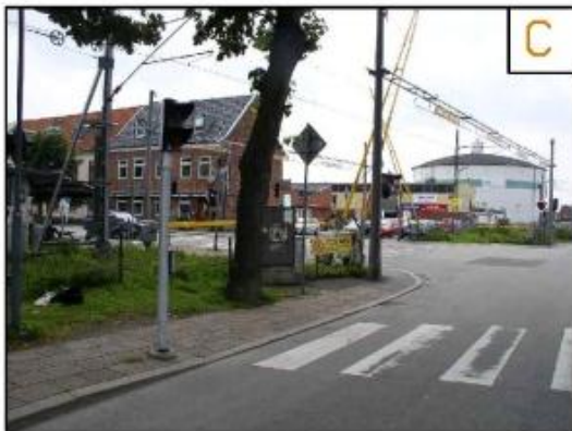
C. Kantstenen är inte avfasad till 0-nivå. Trångt utrymme framför passage samt smal trottoar vid sväng.
