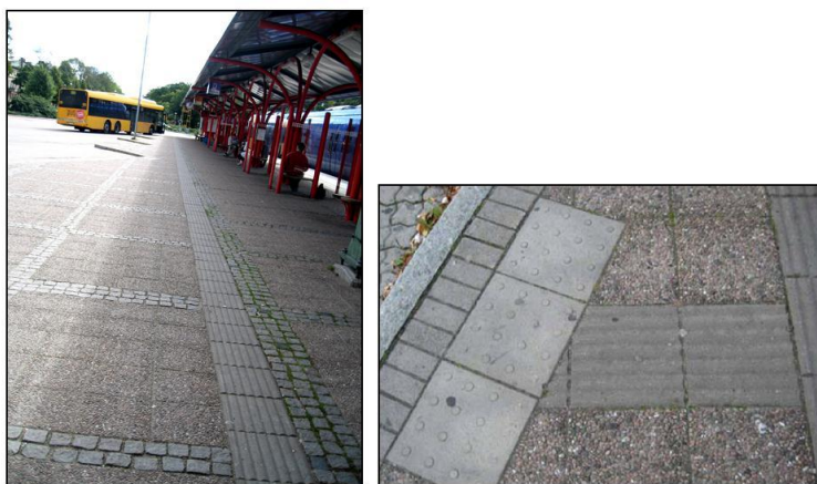
Figur 13. Till vänster visas det taktila stråket till bussterminalen där sinusplattor gränsar till singelplattor på ena sidan och smågatsten på andra sidan. Bilden till höger visar påstignings-zonens taktila plattsättning samt att valyta saknas där förgrening av ledstråket finns.
