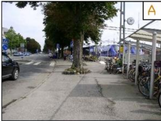
A. Träd mitt i trottoaren och slarvigt parkerade cyklar påverkar den fria passagebredden. Dåligt underhållen markbeläggning.
