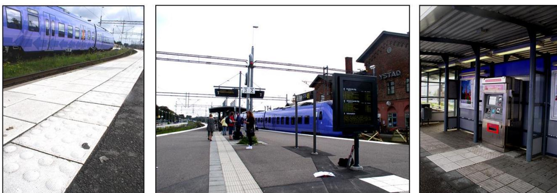
Figur 28. Bilderna är tagna från plattform 2. Till vänster visas plattformens skyddsområde, mittenbilden visar plattformen och den högra bilden visar väderskydd 2 med biljettautomat.
