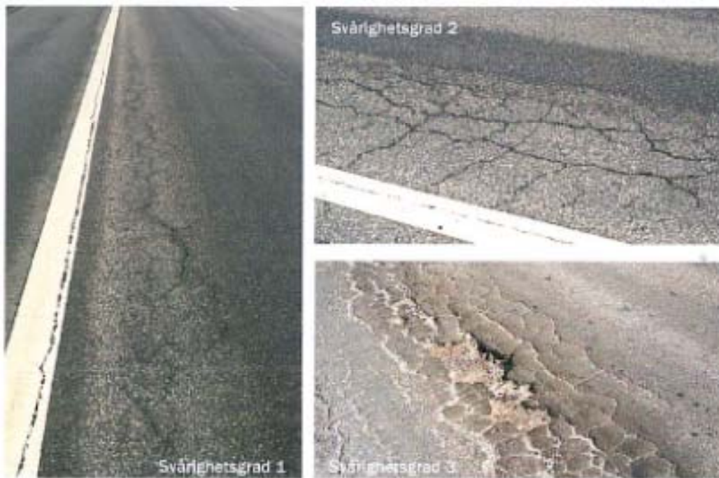
Bild 6.1: Krackelering svårighetsgrad. (Göran, 2003)
