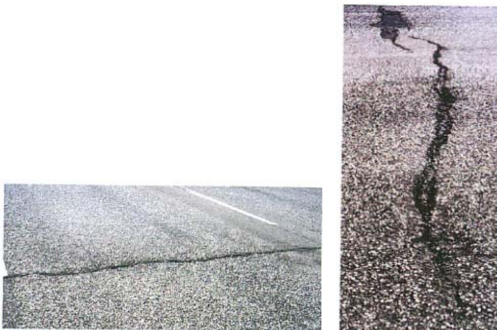
Bild 6.2: Tvärgående sprickor svårighetsgrad 2 och 3. (Göran, 2003)
