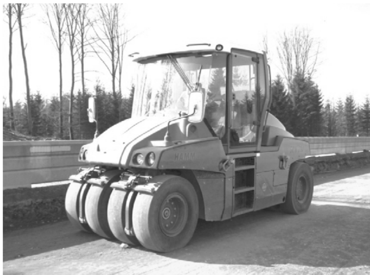
Figur 18 - Gummihjulsvält som används för ytpackning vid ombyggnation av E22, delsträcka Hörby N - Linderöd.
