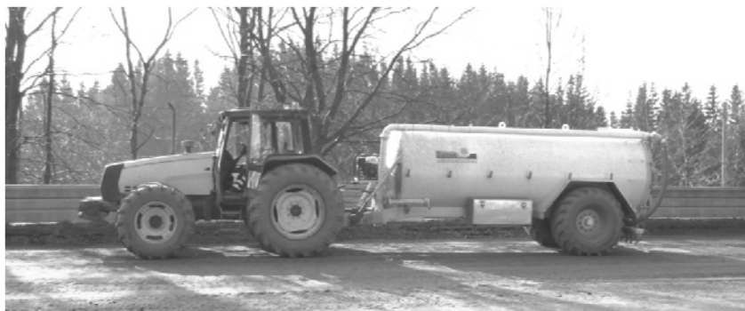
Figur 16 - Spridning av vatten vid ombyggnation av E22, delsträcka Hörby N - Linderöd.
