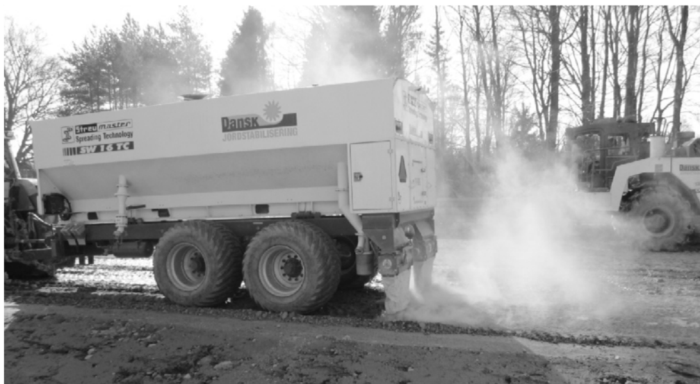
Figur 15 - Spridning av cement vid ombyggnad av E22, delsträcka Hörby N - Linderöd.
