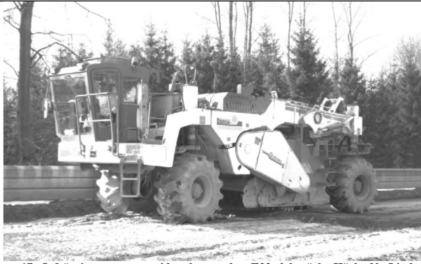
Figur 17 - Infräsning av cement vid ombyggnad av E22, delsträcka Hörby N - Linderöd.
