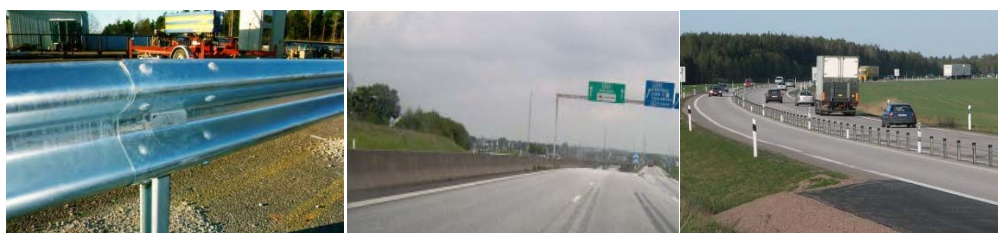
Figur 10. Olika räkestyper. Från vänster till höger; W-profil (Andersson, 2005), betongbarriär och vajerräcke.
