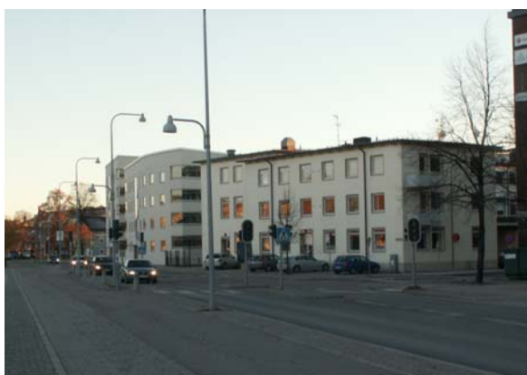
Figur 8 Signalanläggningen på Hamngatan vid Careliigatan
