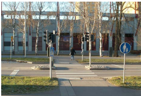
Figur 7 Signalanläggningen på Krongatan
