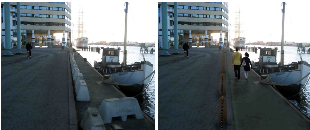
Figur 40. Förslag till ersättning av betonggrisar. T.v. nuvarande och t.h. framtagna visionsbild efter åtgärd. Notera vilken ökad yta och tillgänglighet kajpromenaden skulle få av en mycket enkel åtgärd
