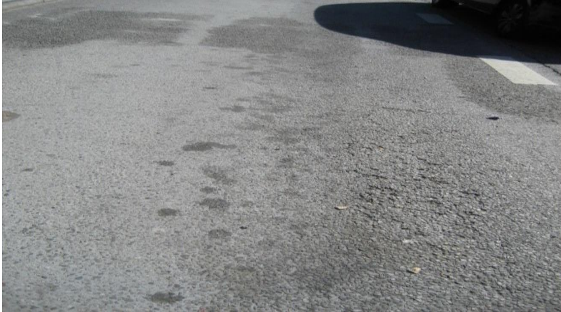
Figur 9 Stensläpp(Gatukontoret, 2014)
