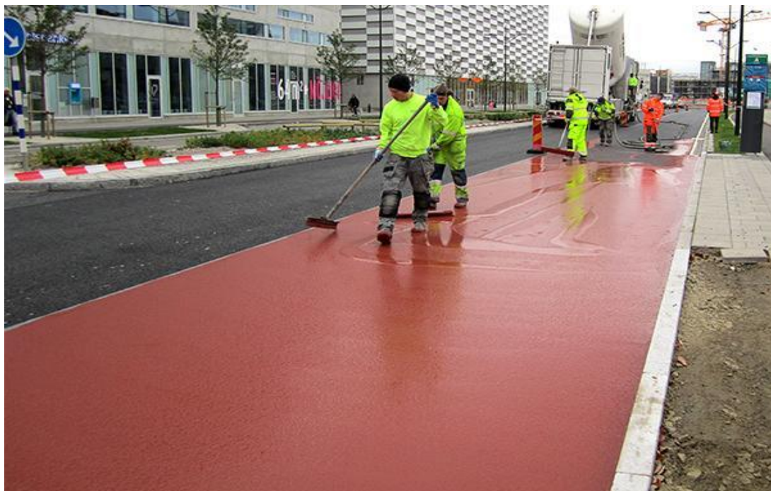
Figur 1 Utläggning av rödfärgad Cementstabiliserad asfalt (Peab, 2014)
