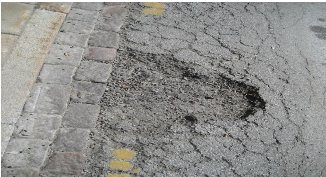
Figur 10 Slaghål(Gatukontoret, 2014)
