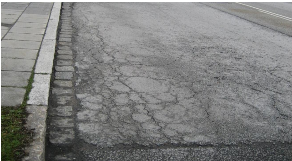
Figur 4 Krackelering(Gatukontoret, 2014)
