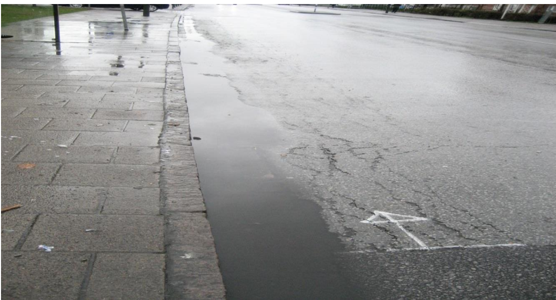
Figur 12 Otillräcklig ytvattenledning(Gatukontoret, 2014)
