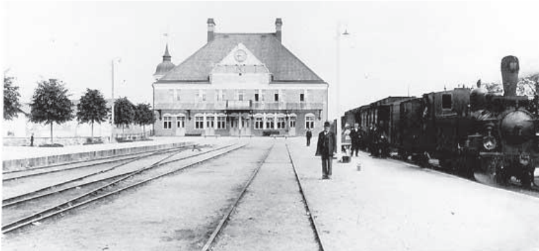
Figur 8: Oskarshamns järnvägsstation (Adell, 1974).
