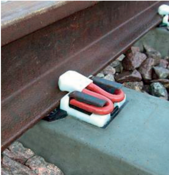
Figur 18: Fastclipbefästning (Pandrol, 2014).
