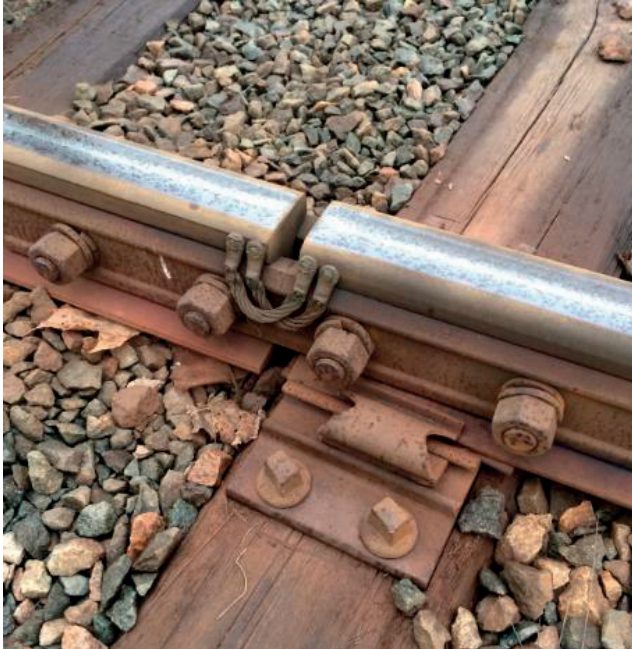
Figur 16: Hey-Backbefästning
