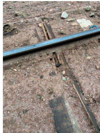
Figur 32: Exempel på en sliper som bör bytas akut.
