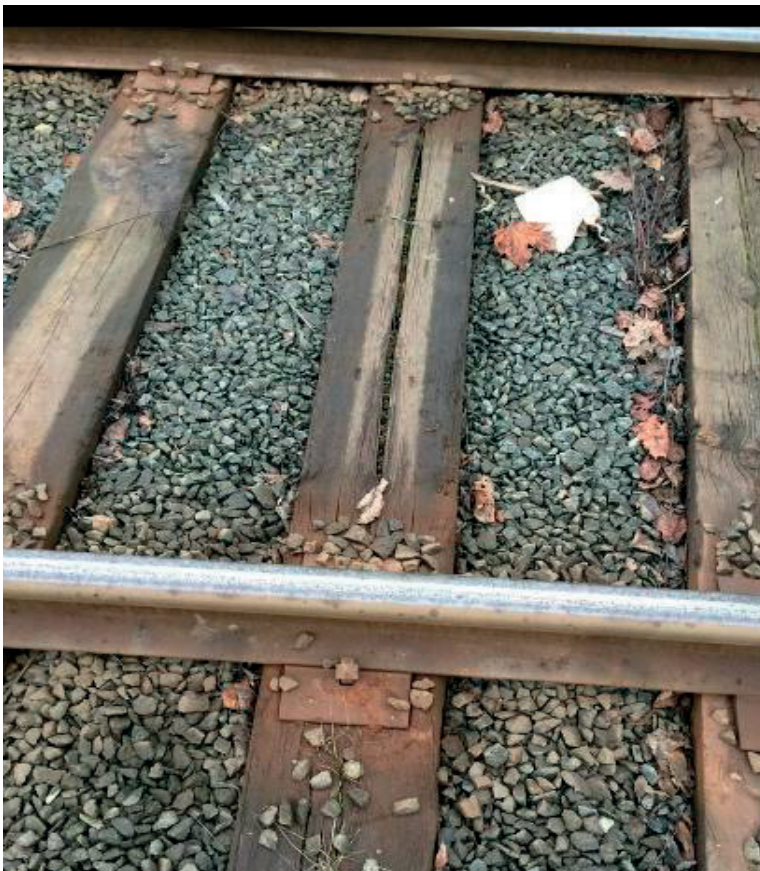
Figur 15: Spikbefästning
