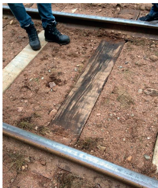
Figur 23: Obehandlad sliiper i ek kombinerad med TCS-sliprar i Hulfsfred.
