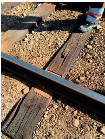
Figur 33: Sliper med underhållsanmärkning.
