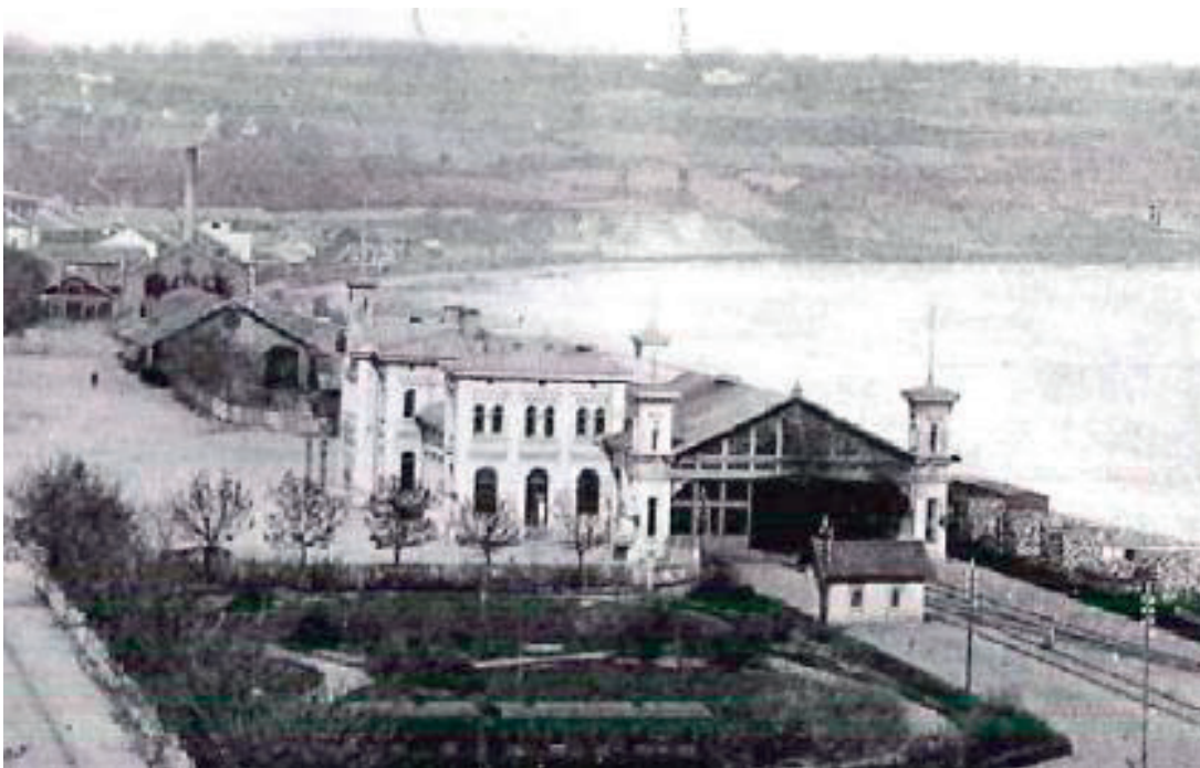
Figur 9: Jönköpings tågstation på Södra Stambanan (Bårström och Granbom, 2012).
