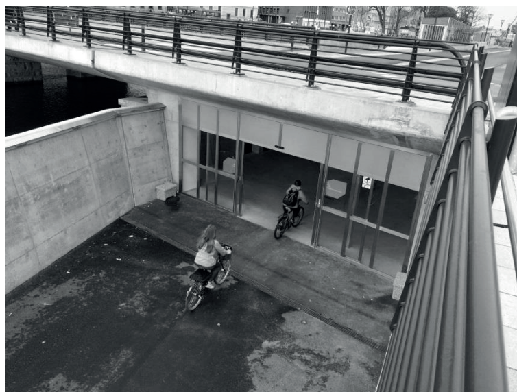
Figur 24 Ingången till det nya garaget, i bakgrunden syns de två nedgångarna via trappor.
