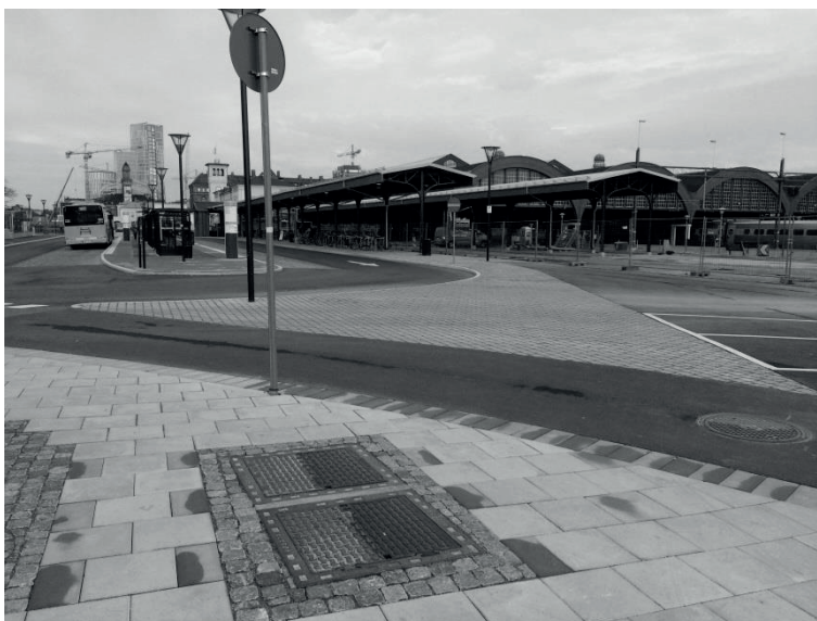
Figur 25 Parkering på gamla perrongen, cykelgaraget ligger under busshållplatsen.
