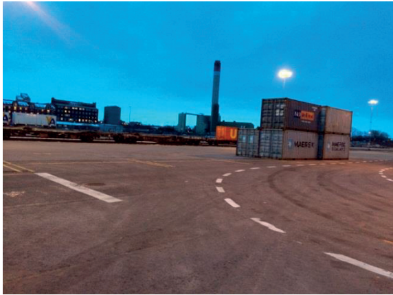
Figur 6-30: Ett tågsätt uppställt på ett av kombiterminalens hanteringsspår. Vad som är uppställningsyta, hanteringsyta och körbana framgår av markeringar i asfalten.
