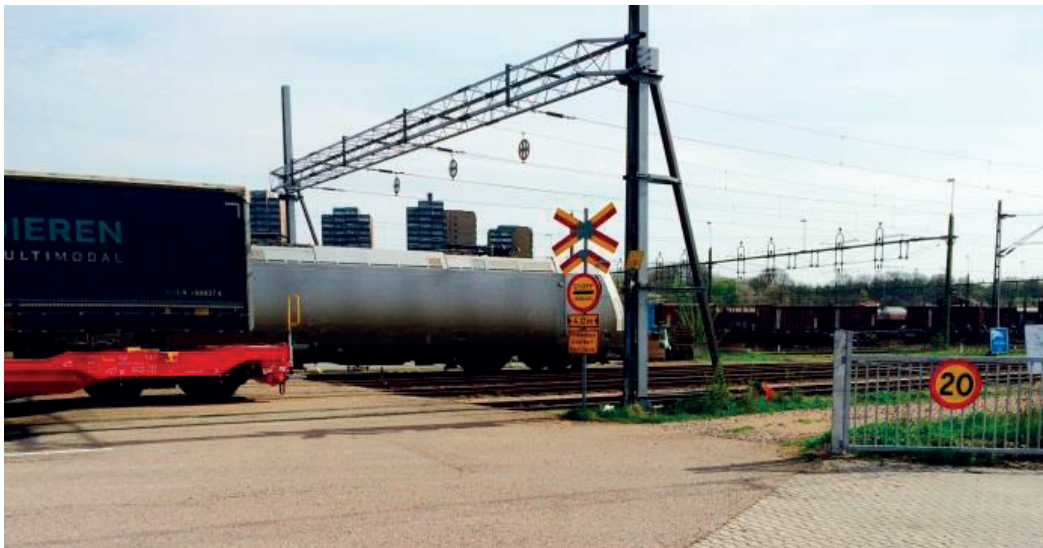
Figur 6-42: Järnvägsspåren är elektrifierade ända fram till terminalens hanteringsspår, vilket möjliggör för fjärrtågoperatörer att växla in tågen med egna lok.
