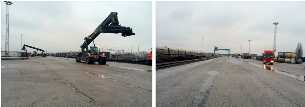
Figur 6-51: Längs hanteringsspåren används den öppna ytan både för extern trafik och enhetslyft.
