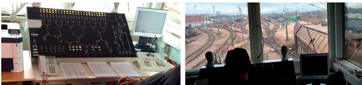
Figur 6-33: I rangertornet styrs verksamheten via radiokontakt med växlingspersonal och med reglage för växlarna inom rangerbangården.
