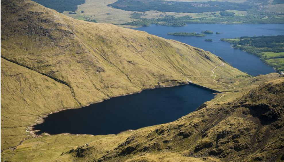
Figur 20. Cruachan pumpkraftverk med det konstgjorda övre magasinet Cruachan reservoir i förgrunden och Loch Awe som utgör nedre magasin i bakgrunden. Källa: (blueyed, 2012)
