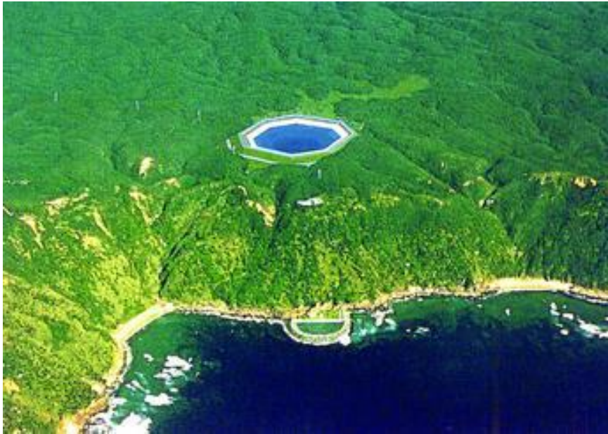
Figur 23. Okinawa Yanbaru havsvattenbaserade pumpkraftverk. Källa: (Rehman, et al., 2015)
