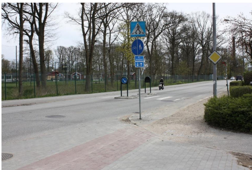
Bild 12 Upphöjd infart med avvikande beläggningmaterial
