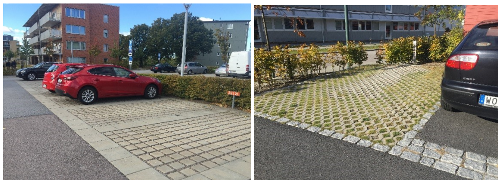
Figur 3.7 Permeabla ytor på parkeringsplatser i området Gyllins Trädgård i Malmö. Till vänster natursten med genomsläppliga fogar och till höger hålsten av betong med mellanliggande gräs.
