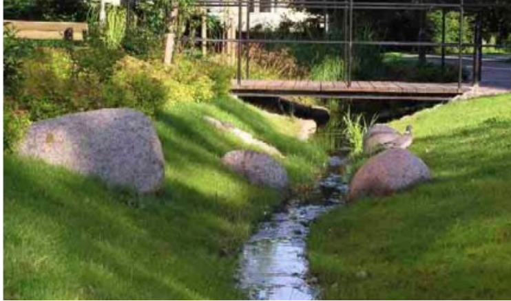
Figur 2.13 Svackdike längs Lönngatan, Augustenborg, Malmö. (Stahre, 2008)
