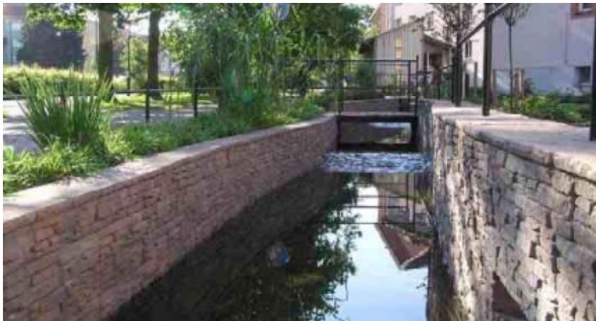
Figur 2.14 Betongkanal längs Lönngatan, Augustenborg, Malmö. (Stahre, 2008)
