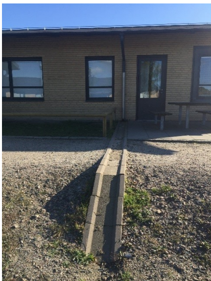
Figur 3.6 Höger: Avrinningsränna till infiltrationsyta på en skola i Gyllins Trädgård i Malmö. Vänster: Infiltration på gräsmatta med kupolbrunn i området Gyllins Trädgård i Malmö.
