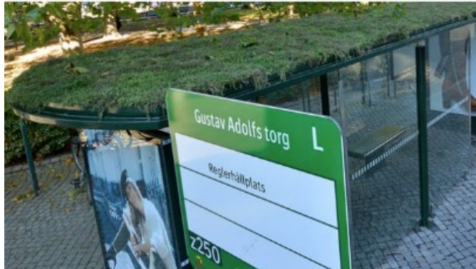
Figur 3.5 Sedumtak på busshållsplats på Gustaf Adolfs Torg i Malmö. (Nilsson, 2013)
