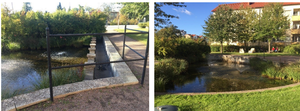
Figur 3.21 Fördröjningsdamm i Augustenborg.
