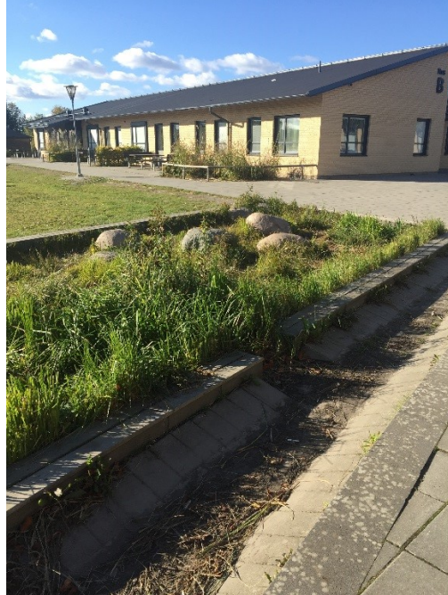
Figur 3.24 Regnbädd kopplad till öppen otäckt kanal på en skola i området Gyllins Trädgård.
