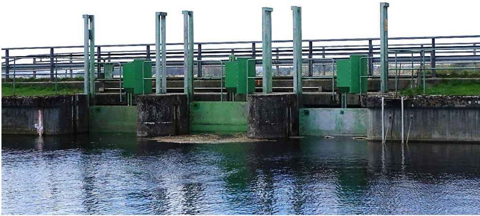
Figur 5 Regleringen till Kävlingeån sett från Vombsjön. Vid reglering förflyttas de tre luckorna i vertikal riktning.
