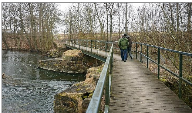
Figur 35 Vy över bron nedströms Rinne- bäck, S.
