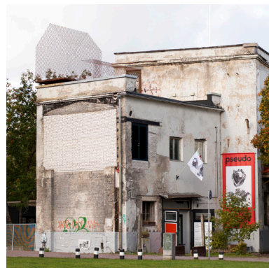
Linnahall. Bakom kalkstensbeklädnaden döljer sig betongsten. EKKM i liknande skick. Bjälklagskanterna är blottade i muren.
