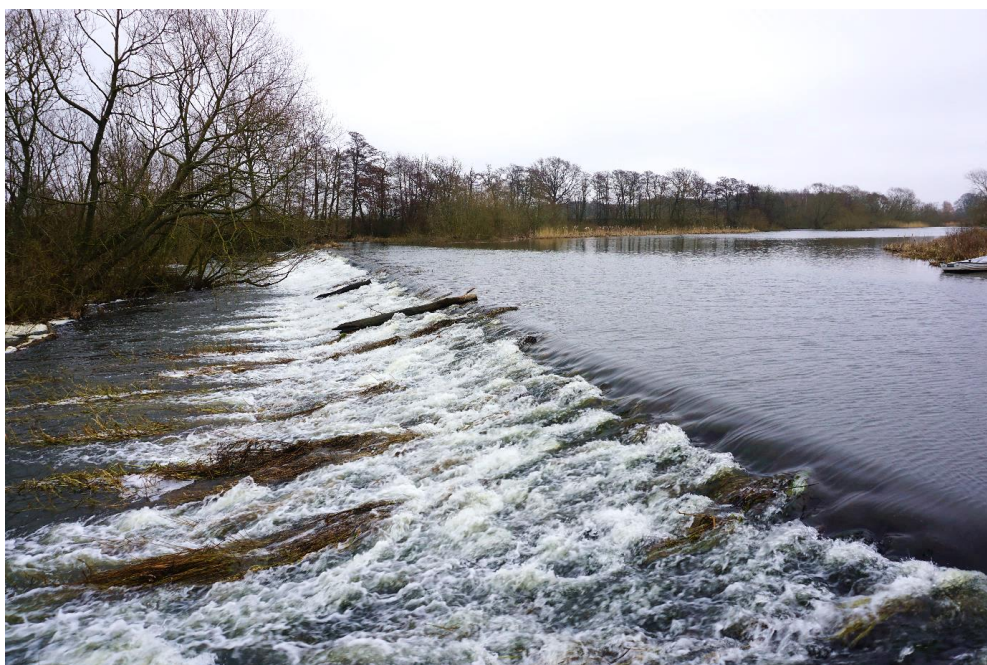
Figur 14 Dämme i natursten vid ett flöde om ca 11 \text{ m}^3/\text{s} i anslutning till Bösmöllan.
