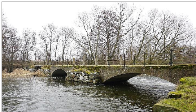
Figur 36 Vy över bron nedströms Bösmöllans dämme, NÖ.
