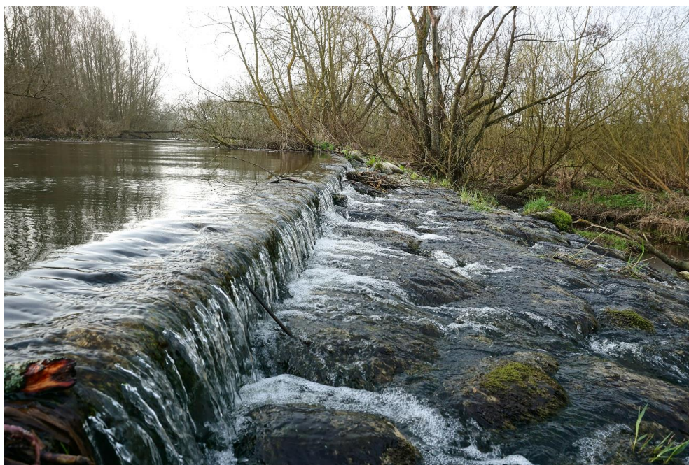
Figur 13 Dämme i betong och natursten i anslutning till vattenkraftverket Farina AB. Vid tidpunkten då bilden togs hade ån ett flöde om ca 9 \text{ m}^3/\text{s} .
