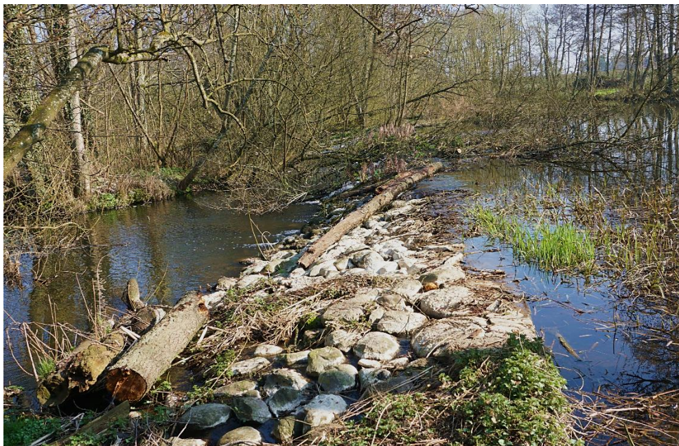
Figur 15 Nedersta delen av dämmet vid Håstad mölla, vilket är utformat med natursten. Bilden är taget vid ett flöde om ca 9 \text{ m}^3/\text{s} .
