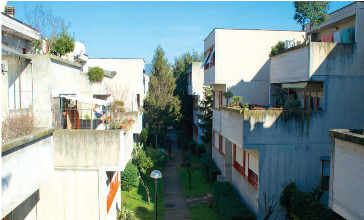
Plate 98 Giancarlo de Carlo: Villaggio Matteotti, Terni, Italy, 1969-75
