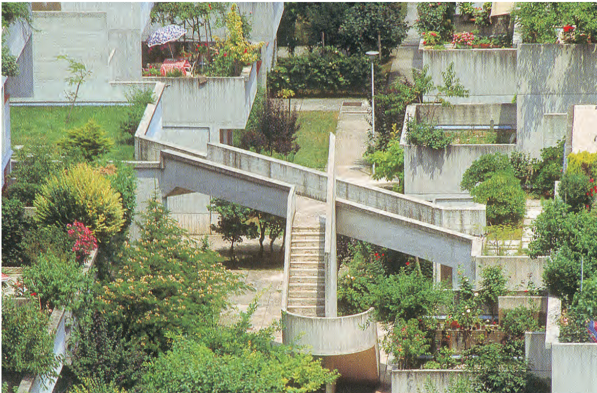
Plate 99 Giancarlo de Carlo: Villaggio Matteotti, Terni, Italy, 1969-75
