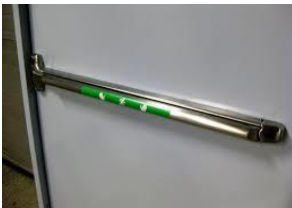
Figur 12. Illustration av beslag utan fallkolv. I aktuellt arbete benämns det Beslag 2.
