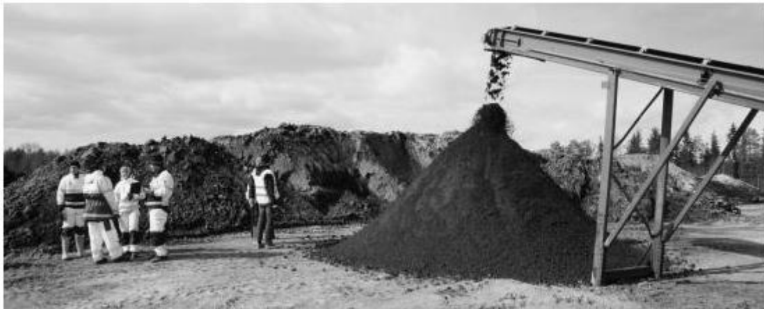
Figur 1.3. Grönlutslam. Omkring 2000 ton grönlutslam är lagrat i bakgrunden. Närmast ses en blandning av grönlutslam och morän som ska användas som tätskikt (Mácsik et al., 2017).
