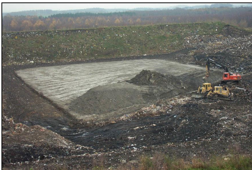
Figur 17. Pågående konstruktion av Biocellreaktor2001:s botten år 2001 (Meijer och Björnsson, 2004)
