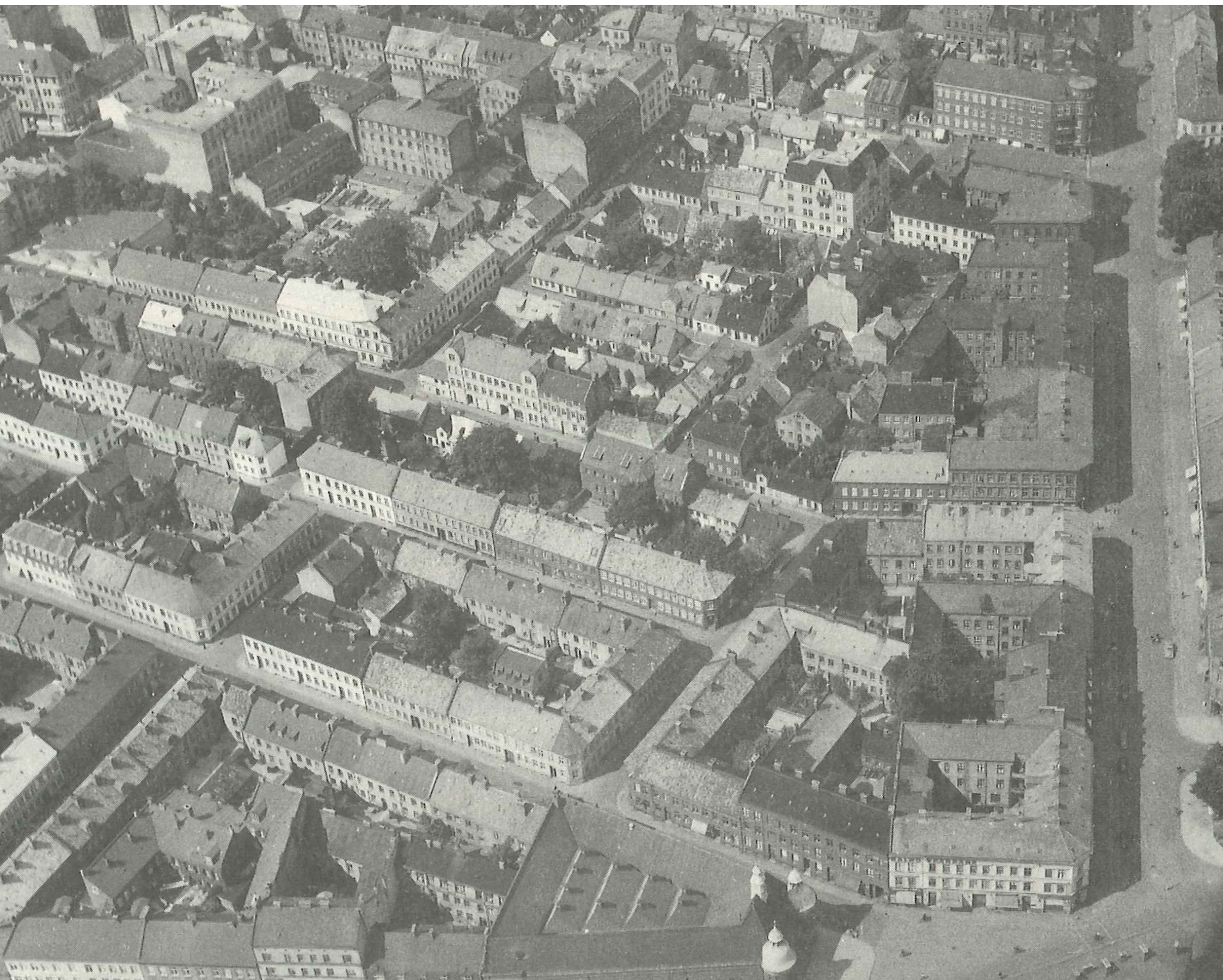
(e) Lugnet innan det revs 1970. (Murath et al. 1989).
