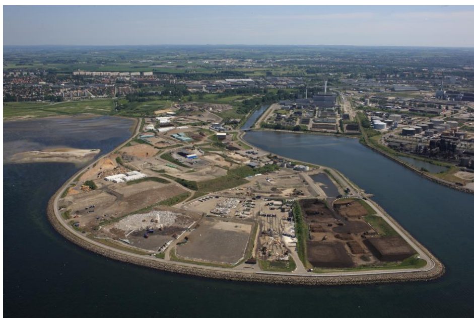
Figur 3 Flygbild över Spillepengs avfallsanläggning
