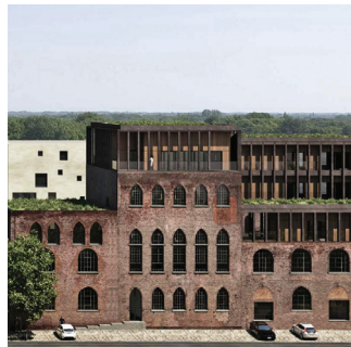
KANAAL, 2016 Coussée & Goris Architects Antwerpen, Belgien
