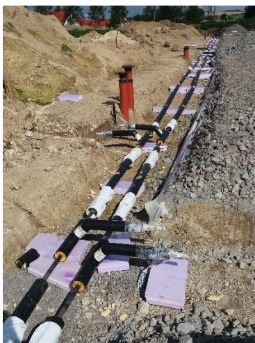
Figur 4. Fjärrvärmeledningar under konstruktion. Avstick på ledningarna kommer leda fjärrvärmen till framtida byggnader.
