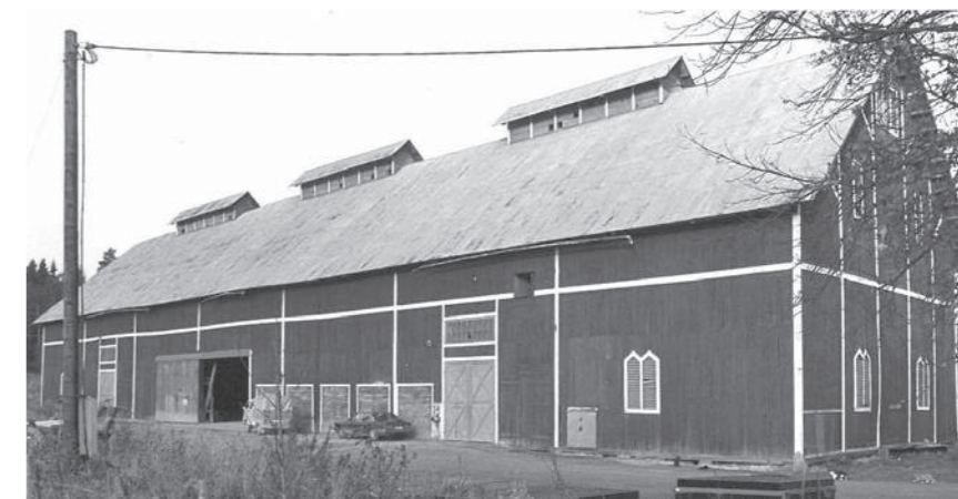
Figur 5. Logen byggs troligtvis omkring 1900-talets början.
