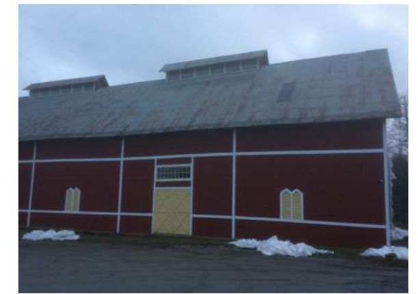
Figur 8. En lättare renovering av logen inleds där bl. a. fasaden målas och fönster och gluggar byts ut.
