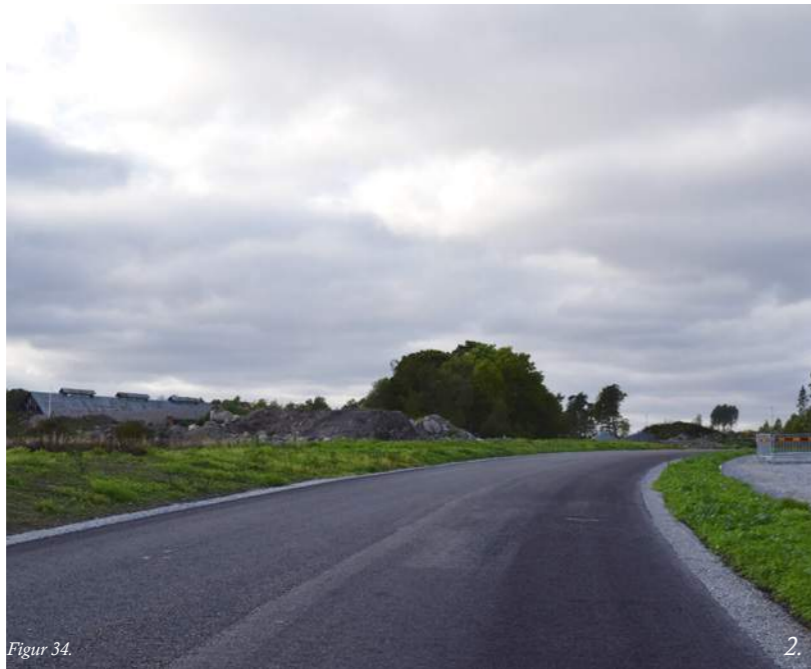
Vy 2, ny väg. Logen syns innan stenladugården från denna väg.
