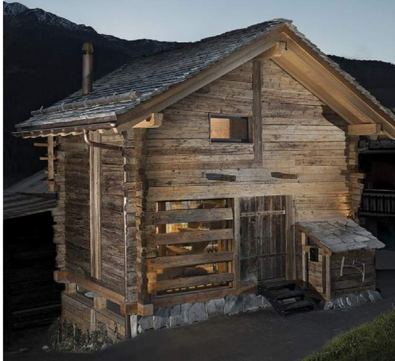
Figur 104. Urtagning i yttervägg för ökat dagsljusinsläpp.
