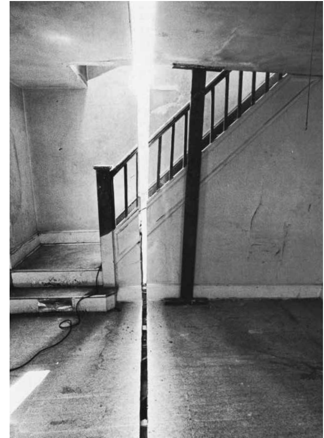
Figur 10. Gordon Matta-Clarks konstverk Splitting (1974), där han med en motorsåg kapade ett nyligen övergivet hus mitt itu. Den våldsamma handlingen har flera effekter som kan tänkas vara unheimlich. Glipan tillåter att det exteriöra tränger in i det interiöra, men på ett helt annat sätt än så som fönster och dörrar gör. Det knäckta huset kan vidare tänkas symbolisera att bandet mellan bostad och boende har brutits. Att hemmet har övergått till att vara något annat.
