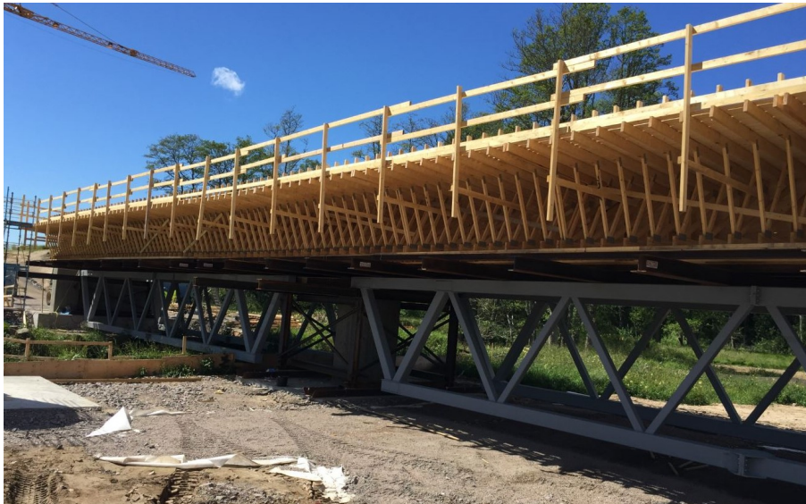
Figur 1.7: Stålfackverk för att bära gjutform under byggskedet av betongbalkbron.
