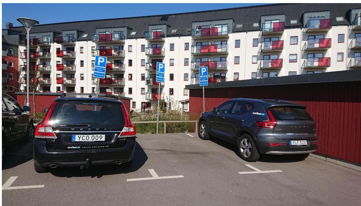
Bild 9. Parkeringsplatser reserverade för bilpool. Vattenverksvägen, Malmö.
