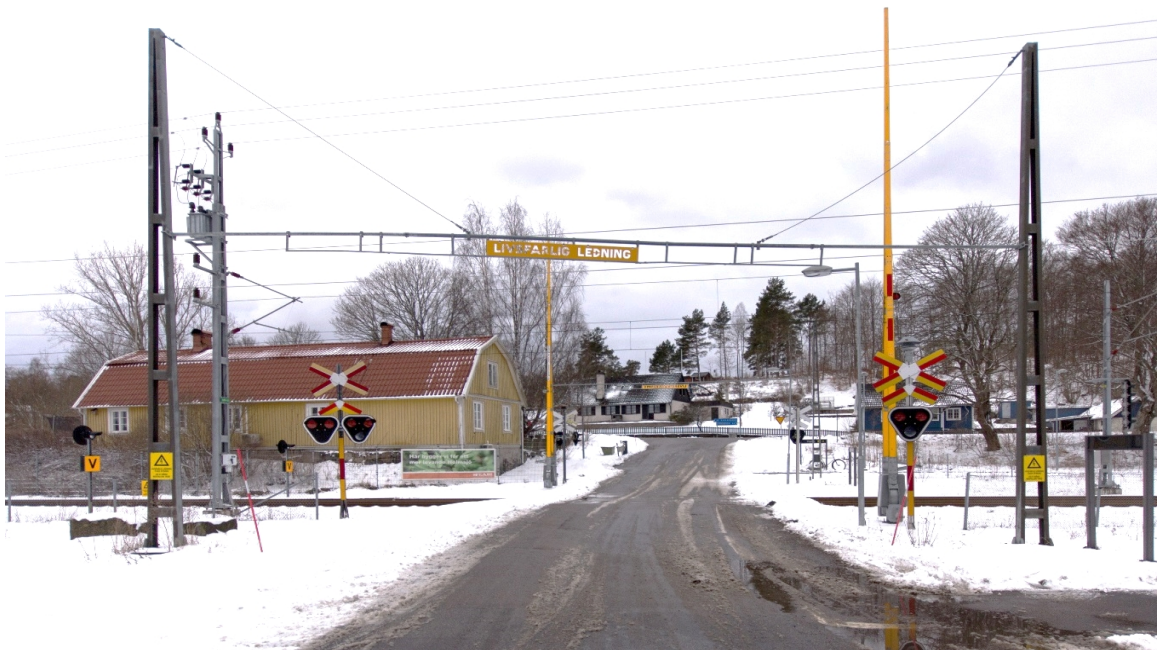
Figur 7. Helbomsanläggning i Holmsjö, Blekinge. Anläggningen har förstärkt ljussignalering i form av extra vägljussignaler.
