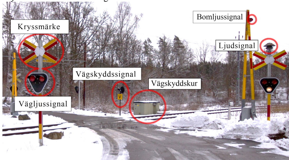
Figur 14. Halvbomsanläggning med några signaltekniska objekt markerade och namngivna.
