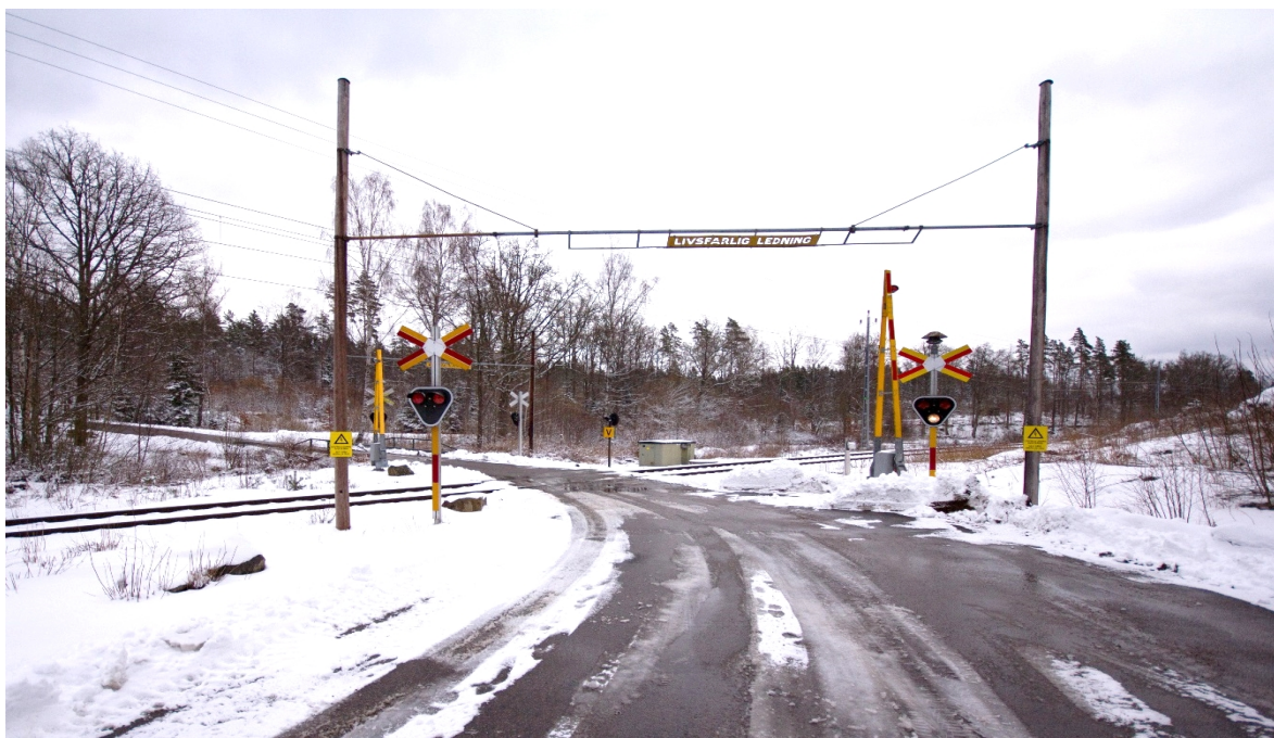
Figur 8. Halvbomsanläggning i Sillhövda, Blekinge.
