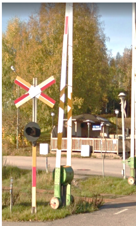
Figur 15. Äldre typ av vägljussignal med bara ett sken (Google Maps, 2013).
