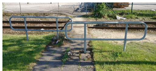
Figur 11. Gångfälla på Terminalgatan i Malmö.
