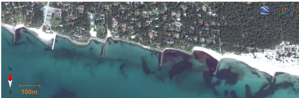
Fig. 16. Bilden är tagen från Google Earth och visar Löderup strandbad ovanifrån. I havet, vinkelrätt mot stranden, går det att se sex stycken hövder. Sand har ansamlats uppströms majoriteten av hövderna och gett upphov till det typiska tandade mönstret på kustlinjen. Vidare användes bilden som underlag för att underlätta uppskattningen av undersökningsområdets och hövdernas storlek.
