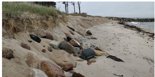
Fig. 15. Längre österut på sandstranden, fortfarande väster om hövd 5, är stranden uppdelad i två etager. Under fältbesöket observerades kornströmning från det övre partiet, ner mot den flacka sandstranden. I bakre delen av bilden, syns början på hövd 5. Foto: Nathalie Jancsak.
