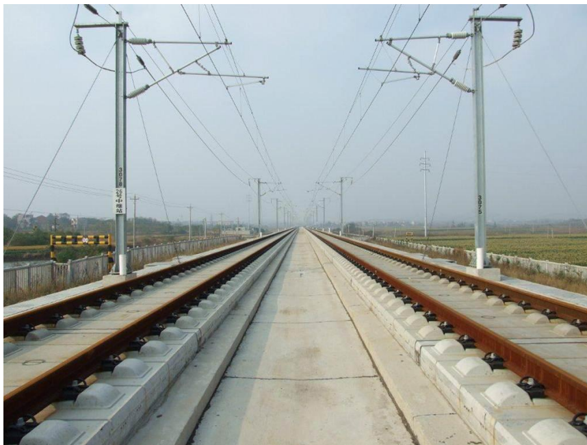
Figur 2: Ballastfritt spår (Conico 8 million city).
