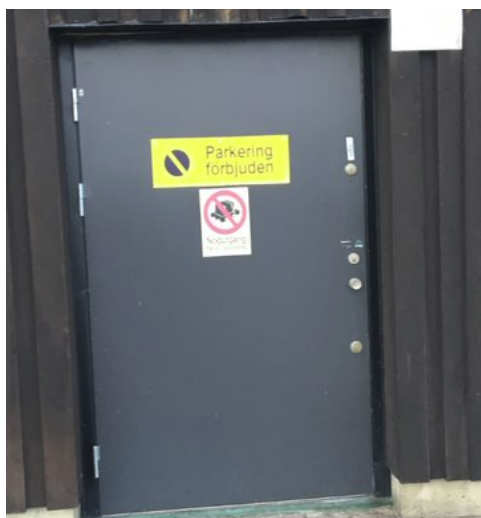
Figur 7. Utsidan av utrymningsväg.
