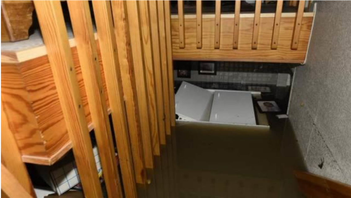
Figur 5. Bild på Kristins källartrappa när vattnet börjat sjunka undan. Notera tidigare nivå på tapeten. Foto: Privat.
