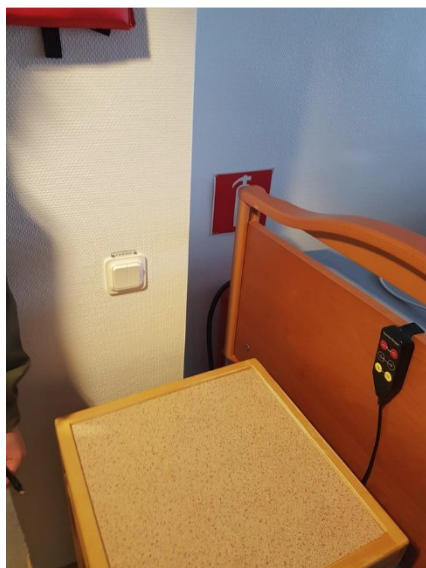
Figur 9. Brandsläckare blockerad av vårdbädd i änden av korridor.
