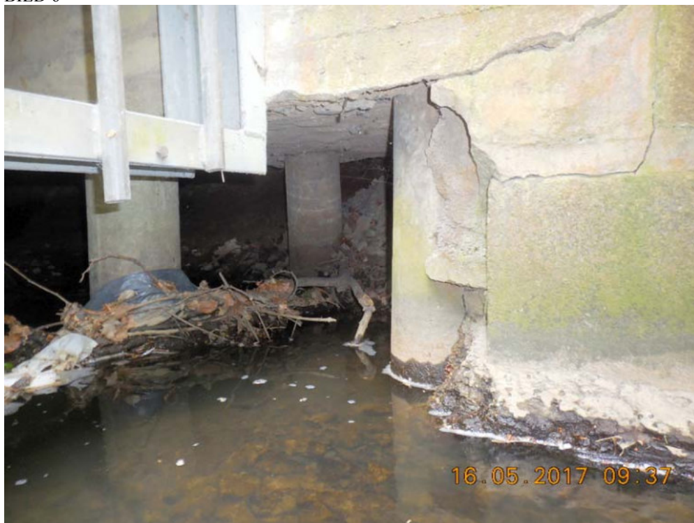
BILDEN VISAR PÅLFUNDAMENT OCH PÅLAR VID INLOPP MOT ÖSTER ÅTGÄRDER M.M. ENLIGT REDOVISNING PÅ LITTERA 6
