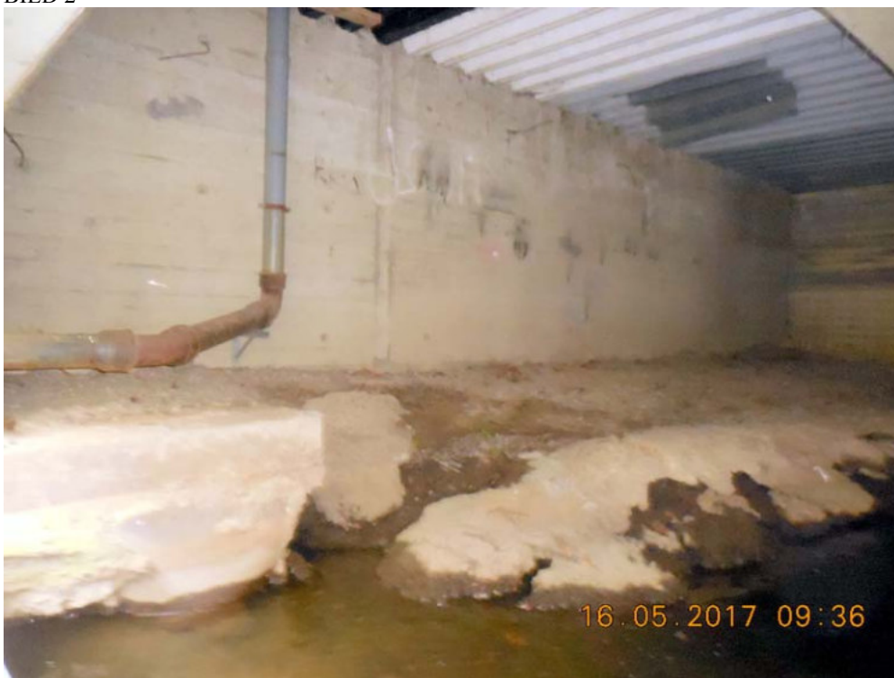
BILDEN VISAR PÅLFUNDAMENT / GRUNDBALKAR OCH KÄLLARVÄGG MOT SÖDER ÅTGÄRDER M.M. ENLIGT REDOVISNING PÅ LITTERA 2
