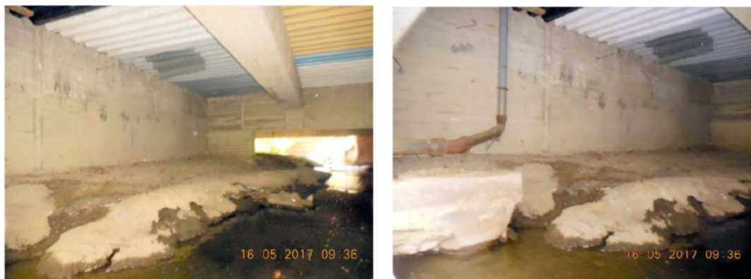
Figur 31. T.v bild på befintlig källare i byggnad D (Bilaga 15)
