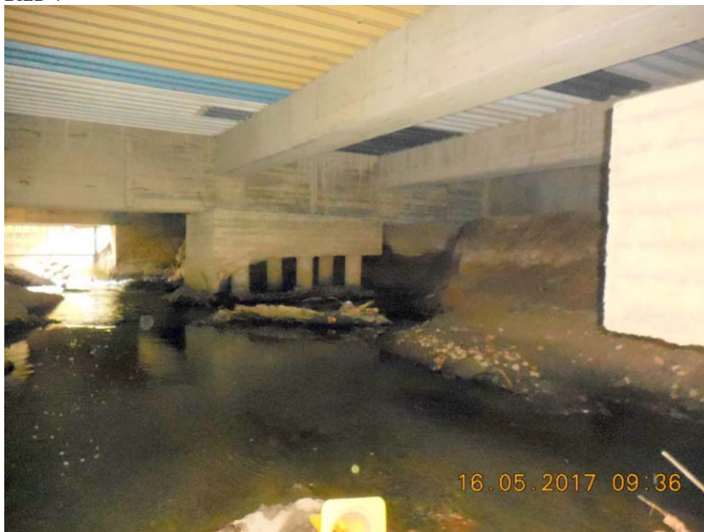
BILDEN VISAR PÅLFUNDAMENT / PRIMÄRA GRUNDBALKAR UNDER BYGGNADEN ÅTGÄRDER M.M. ENLIGT REDOVISNING PÅ LITTERA 4
