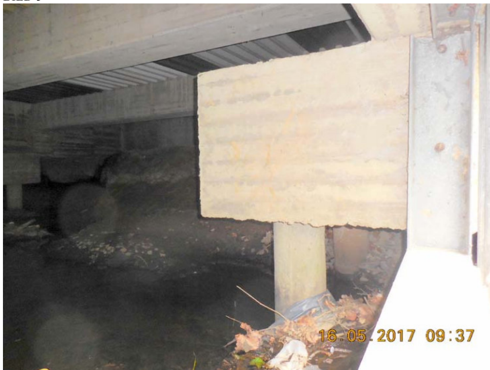
BILDEN VISAR PÅLFUNDAMENT OCH PÅLAR VID INLOPP MOT ÖSTER ÅTGÄRDER M.M. ENLIGT REDOVISNING PÅ LITTERA 5
