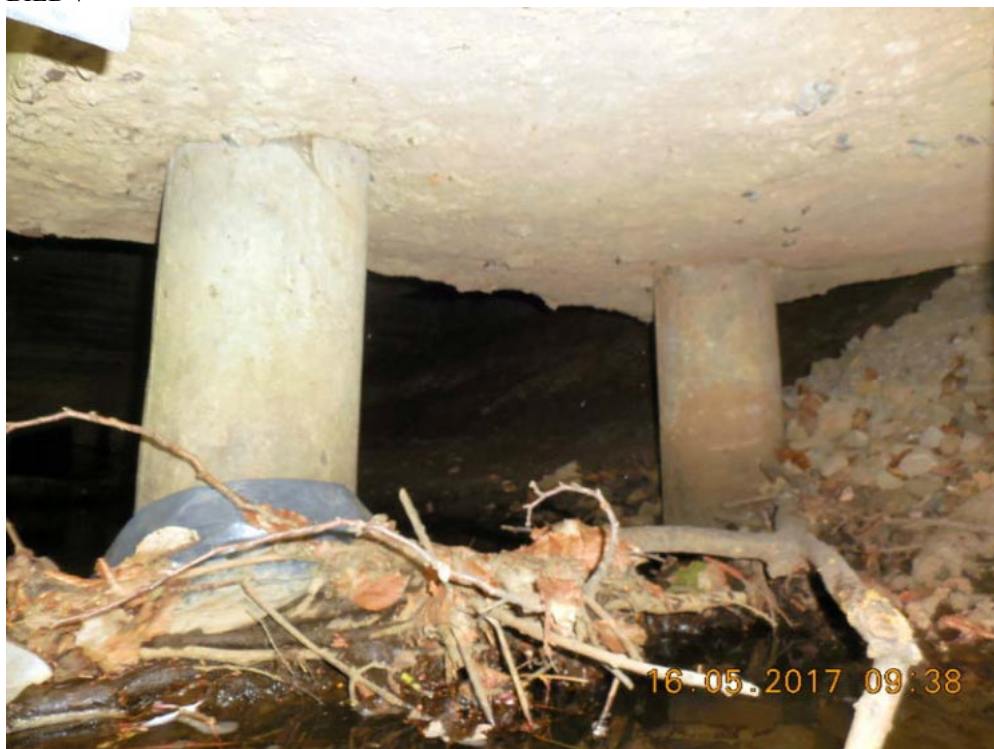
BILDEN VISAR PÅLFUNDAMENT OCH PÅLAR OCH VID INLOPP MOT ÖSTER ÅTGÄRDER M.M. ENLIGT REDOVISNING PÅ LITTERA 7
