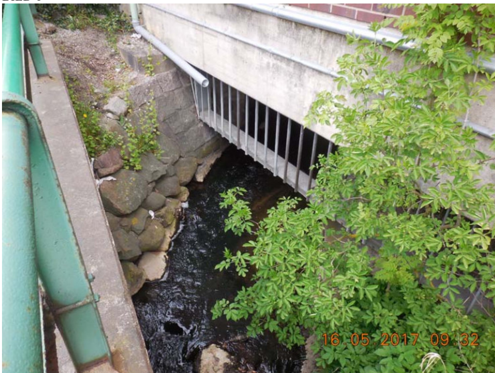
BILDEN VISAR BÄCK MED STENLAGDA SLÄNTER VID UTLOPP MOT VÄSTER ÅTGÄRDER M.M. ENLIGT REDOVISNING PÅ LITTERA 1
