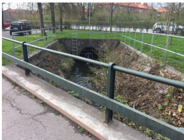
Figur 27. Kulverten börjar i utloppet med stenmurar vid sidan och där Lussebäcken rinner in under Landskronavägen (Gabriella Casselgård)
