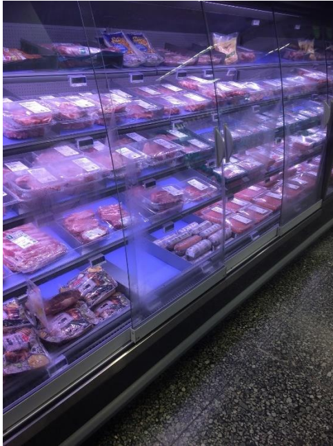
Figur C.4 Kylskåp med skjuddörr, här fylld med charkuterier. Samma utformning användes även för mejerivaror. Skjuddörrarna verkade inte vara tätslutande överhuvudtaget. Ett flertal displayer av denna typ förekom, till synes alla från samma tillverkare.
