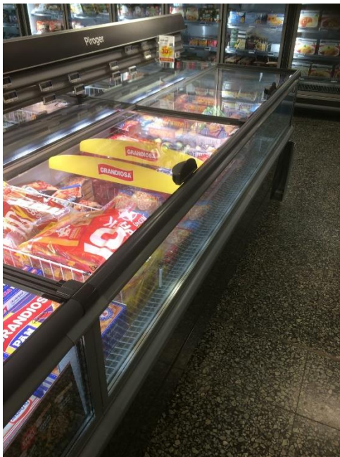
Figur C.7 Frysbox med skjutdörr. Den var här fylld med pizza och pommes frites, men användes till de flesta sorters frysta varor. Till synes det vanligaste utförandet av frys.
